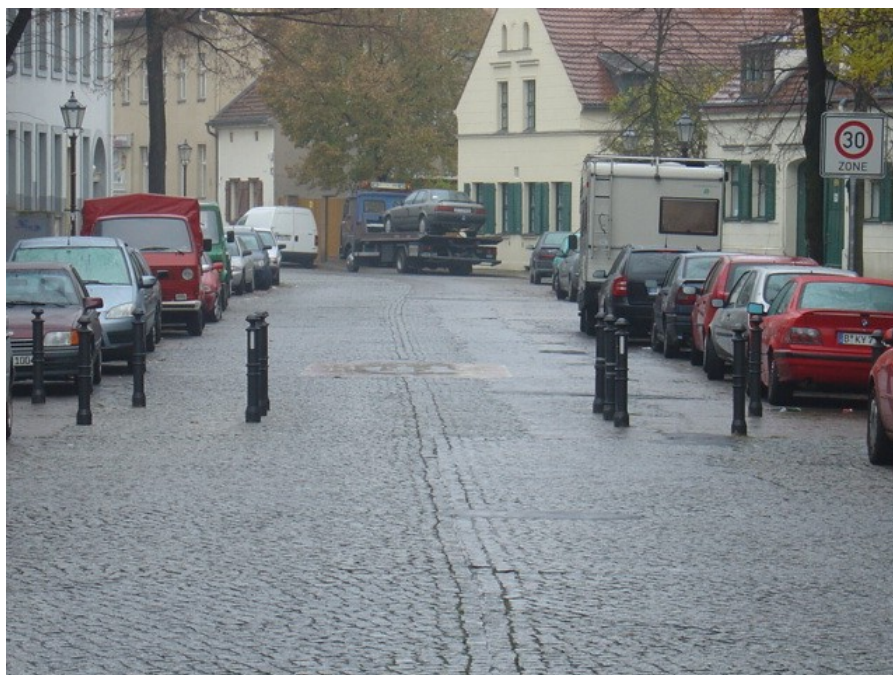
Fot. nr 05 Przykład zawężenia jezdni
