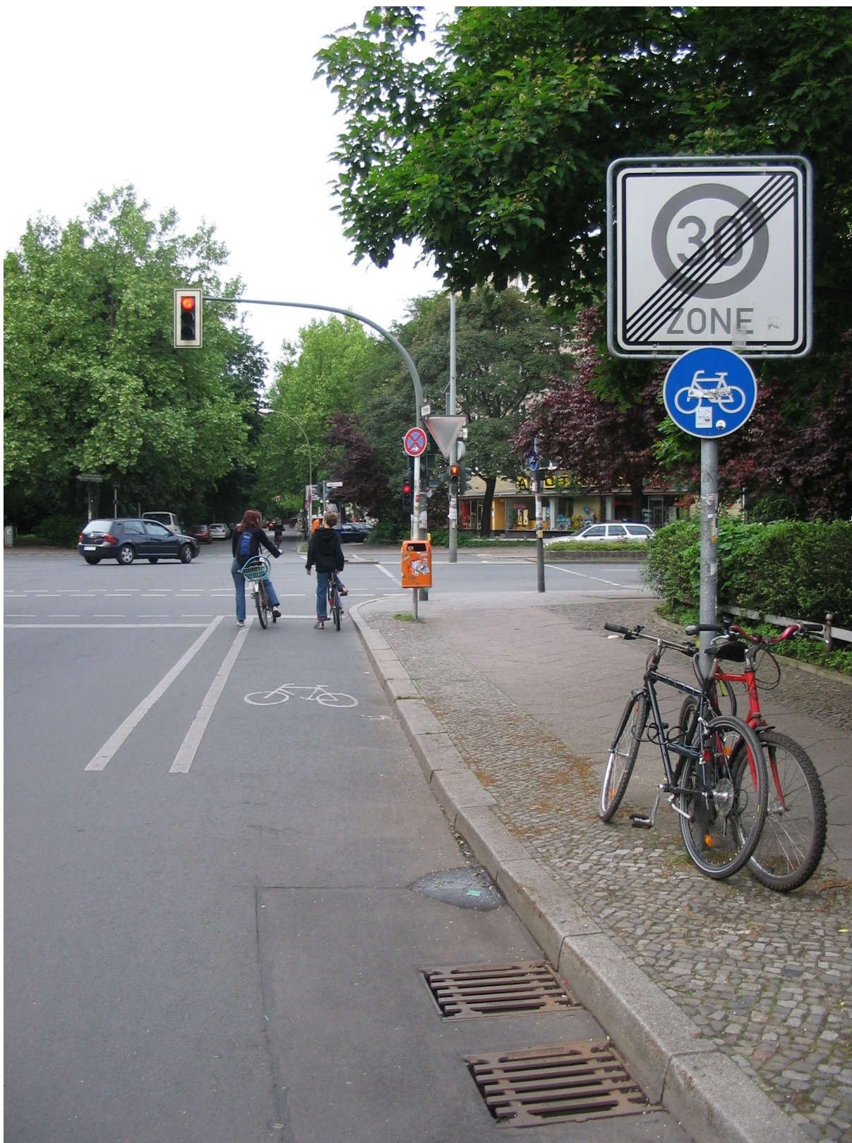
Fot. nr 02 Wyjazd ze strefy Tempo 30 z sygnalizacją świetlną wraz z tzw. pasem filtrującym
