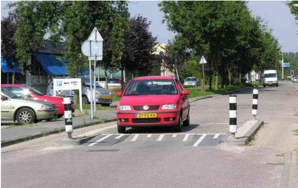
Rys.5 Próg zwalniający dla samochodów – rowerzyści jadą obok progu bez zwalniania
