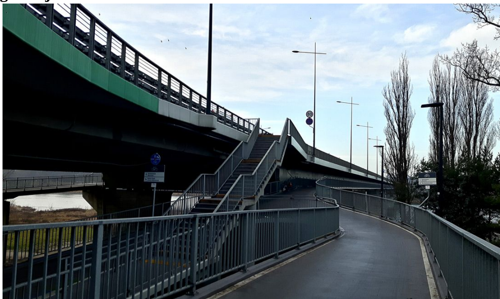
Rys. 3. Kładka Łazienkowska – widok na zachód na prawym brzegu Wisły.
