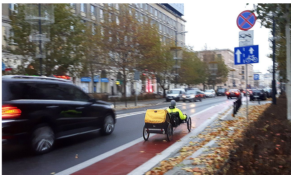
Rys. 3. Pas rowerowy na ul. Świętokrzyskiej w okolicy pl. Powstańców Warszawy, widok z południowo-wschodniego rogu w kierunku wschodnim.
