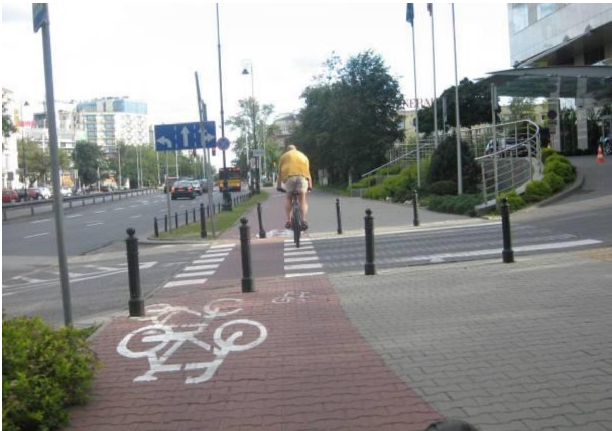
Ul. Belwederska/ul. Spacerowa – trasa 3. Czarny słupek po lewej stronie przed przejazdem rowerowym niepotrzebnie stoi na drodze dla rowerów, bo obok niego jest sztyca znaku drogowego. Natomiast za przejazdem rowerowym sztyca znaku drogowego znajduje się w skrajni, więc powinna zostać ustawiona w miejscu słupka, a obydwie słupki po lewej powinny zostać usunięte.
