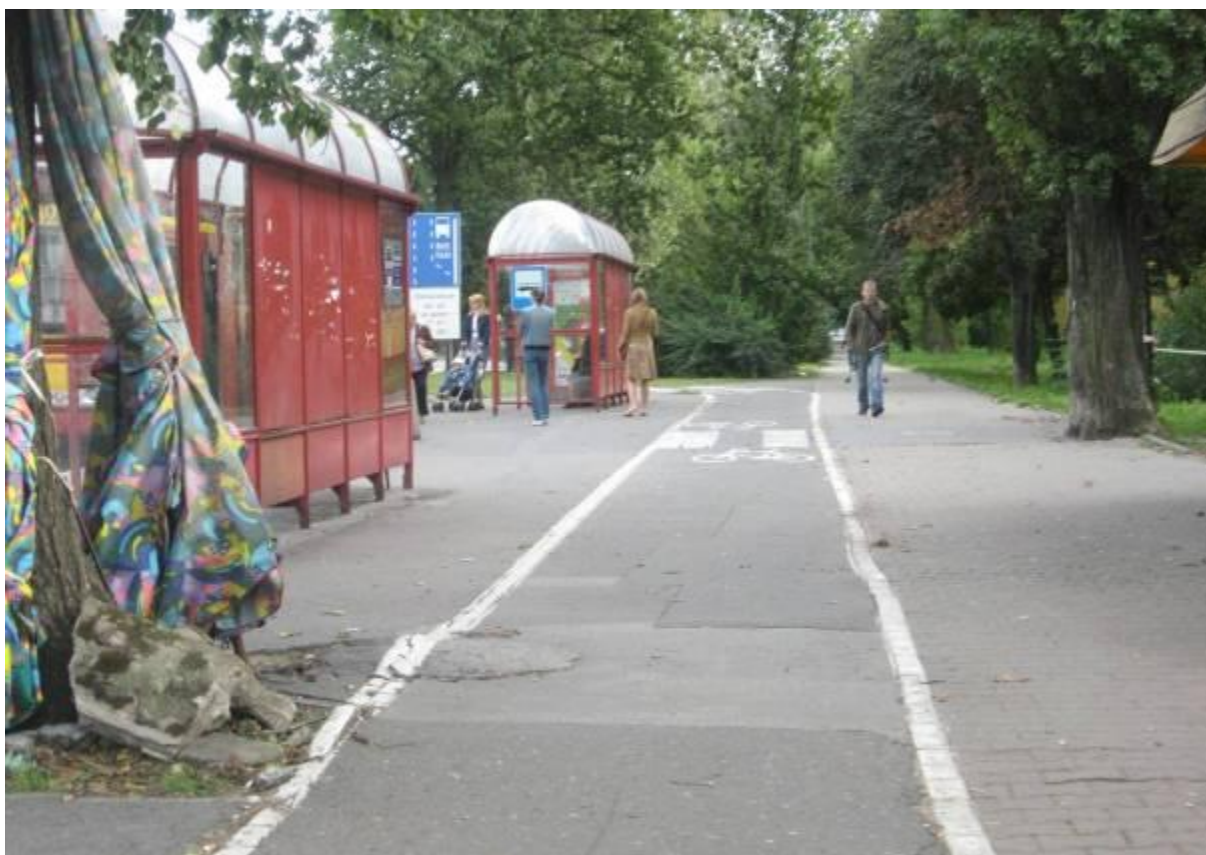
Ul. Sobieskiego/ul. Dolna – trasa 3. Zły stan nawierzchni drogi dla rowerów przy przystanku autobusowym. Kolorowe parasole oparte o drzewo po lewej są tu zostawiane przez handlarzy, którzy blokują chodnik po prawej swoimi straganami, co powoduje ruch pieszych po drodze dla rowerów.
