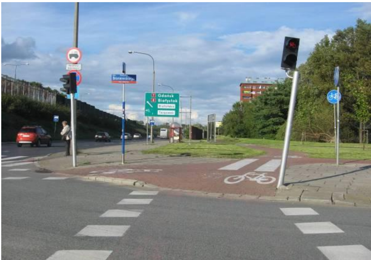
Ul. Broniewskiego/Trasa Armii Krajowej- trasa 5. Jeden ze słupów sygnalizacji świetlnej znajdujący się w skrajni drogi dla rowerów.
