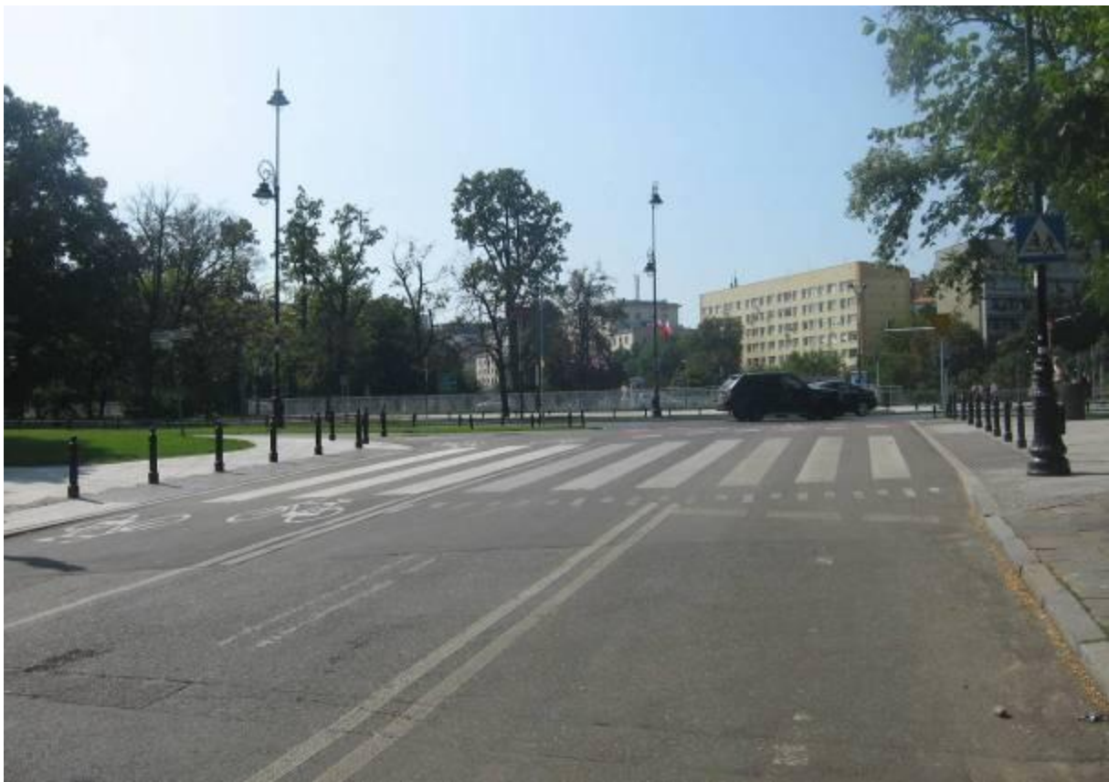
Al. Ujazdowskie / ul. Agrykola – przejazd rowerowy i przejście dla pieszych przeprowadzone grzbietem progu zwalniającego
