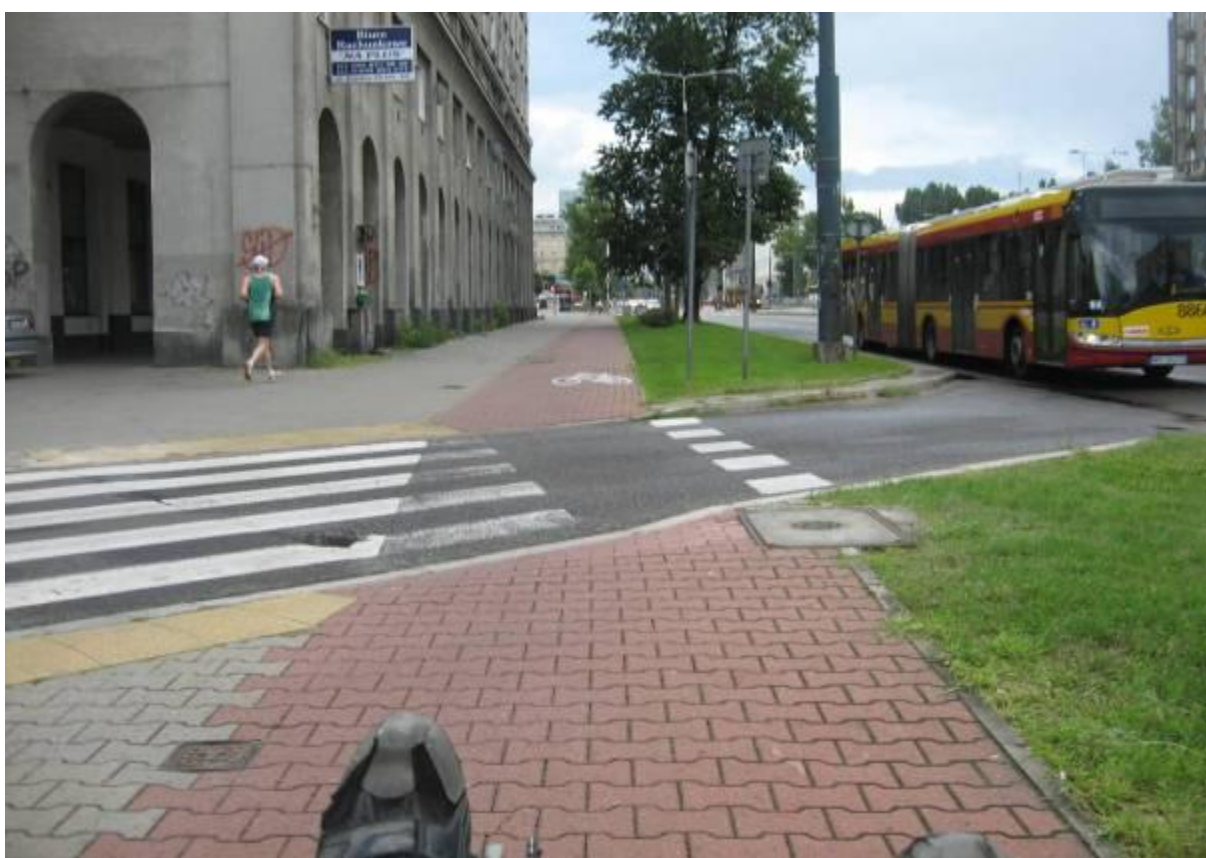
Al. Jana Pawła II/ul. Dzielna – trasa 5. Krawężnik obniżony tylko po lewej stronie przejazdu rowerowego (zapewne przyczyną problemu jest widoczna po prawej studnia teletechniczna, którą trzeba było by przebudować, żeby można było prawidłowo obniżyć krawężnik).
