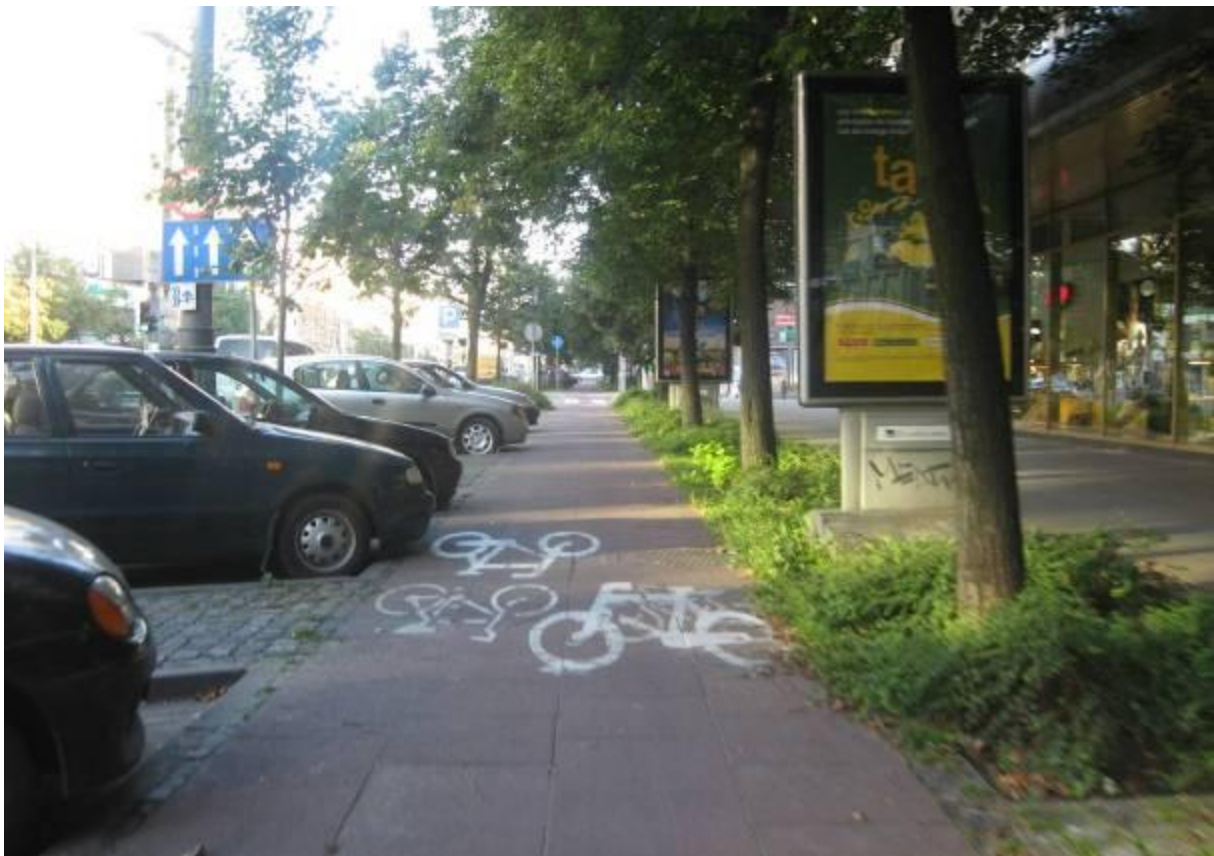
Ul. Marszałkowska – trasa 4. Brak odstępu pomiędzy miejscami parkingowymi a drogą dla rowerów powoduje jej zawężanie przez zaparkowane samochody. Z drugiej strony na korzystanie z całej szerokości drogi dla rowerów (czyli 2m) nie pozwala roślinność w skrajni, która zasłania sobą krawężniki przy drzewach równoległe do drogi dla rowerów.
