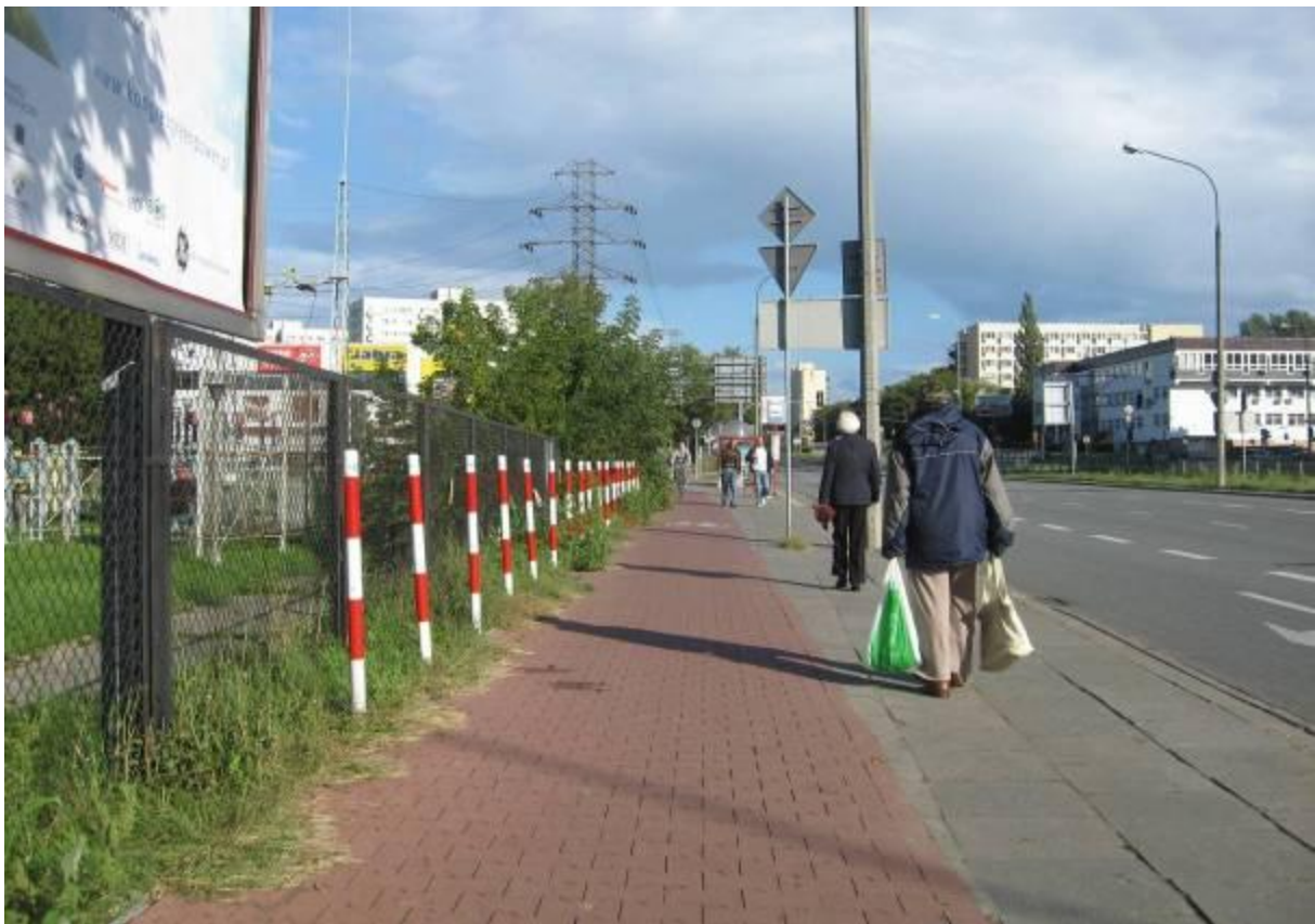
Ul. Broniewskiego –trasa 5. Słupki po lewej stronie ustawione w skrajni drogi dla rowerów oraz chodnik zawężony przez latarnię i sztycę znaku drogowego, co przyczynia się do ruchu pieszego po drodze dla rowerów.
