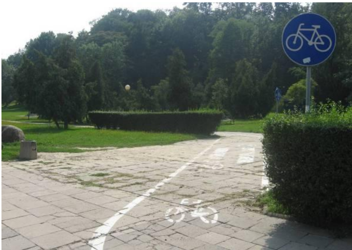
Ul. Browarna – droga dla rowerów z płyt chodnikowych na odcinku od ul. Karowej do ul. Oboźnej
