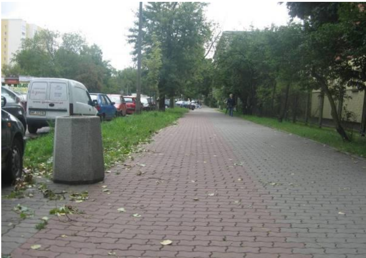
ul. Namysłowska – trasa 2 Niewłaściwie ustawiony kosz na śmieci przyczynia się do ruchu pieszego w poprzek drogi dla rowerów.
