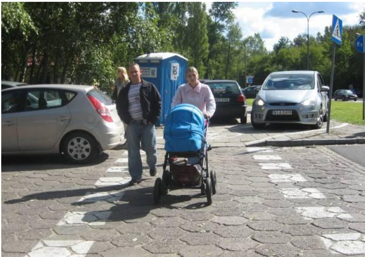
Ul. Wybrzeże Helskie/ul. Starzyńskiego – trasa 2. Ruch samochodów i pieszych po drodze dla rowerów oraz parkowanie samochodów na chodniku przy ogrodzie zoologicznym.
