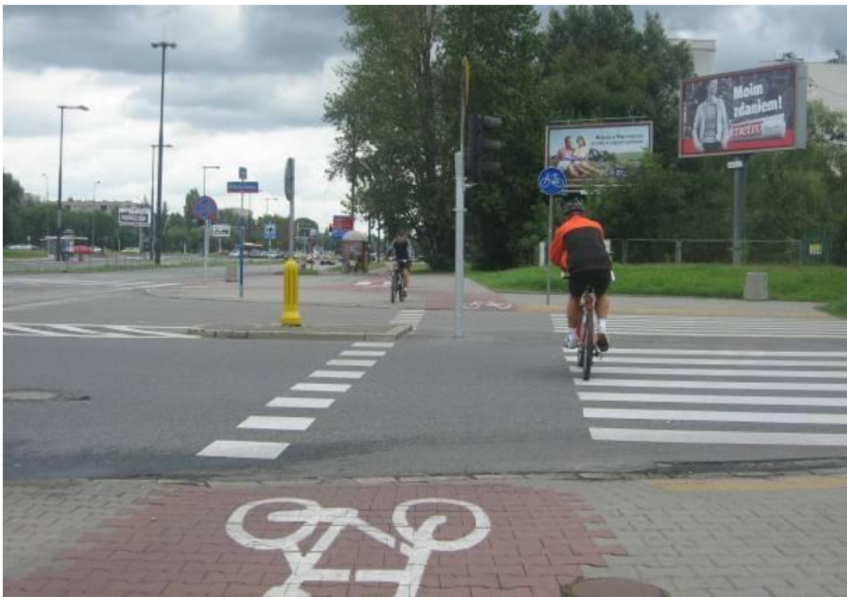
Ul. Sobieskiego/ul. Idzikowskiego – trasa 3. Słup sygnalizacji świetlnej na środku przejazdu rowerowego. Na innych skrzyżowaniach ul. Sobieskiego słupy sygnalizacji świetlnej znajdują się w skrajni drogi dla rowerów.
