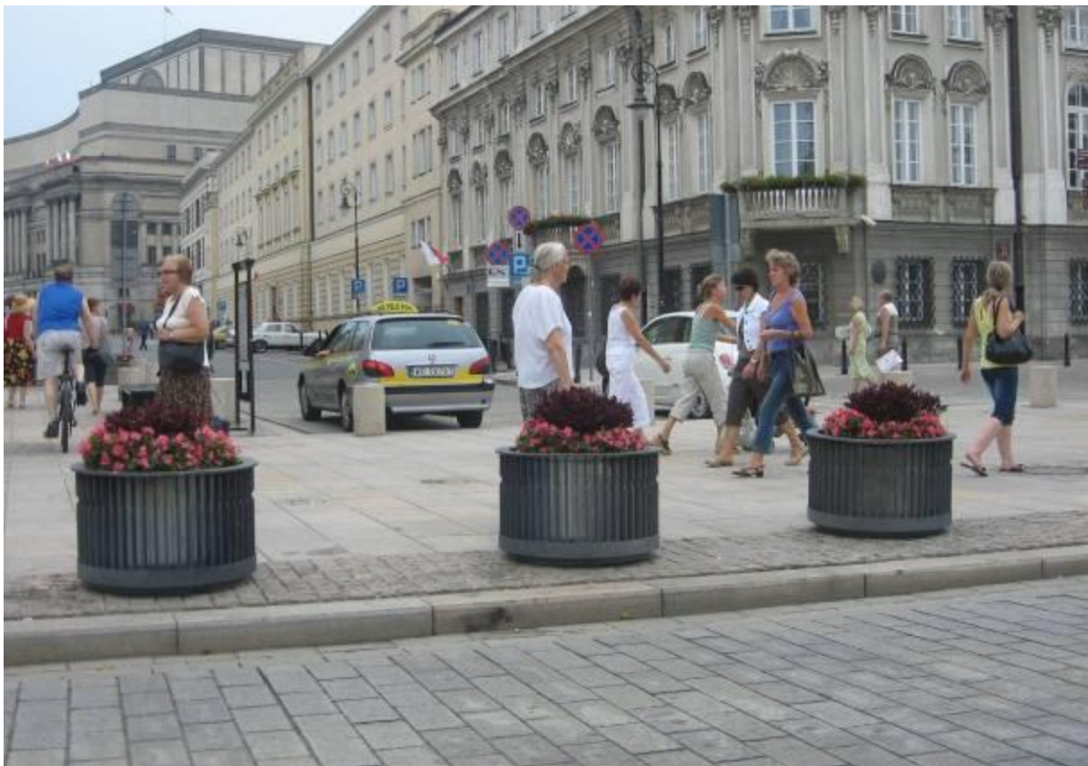
Krakowskie Przedmieście/ul. Trębacka - brak dostępnego dla rowerzystów połączenia ślepego zakończenia ulicy z jezdnią. Podobnie zakończona została ul. Oboźna i ul. Traugutta.
