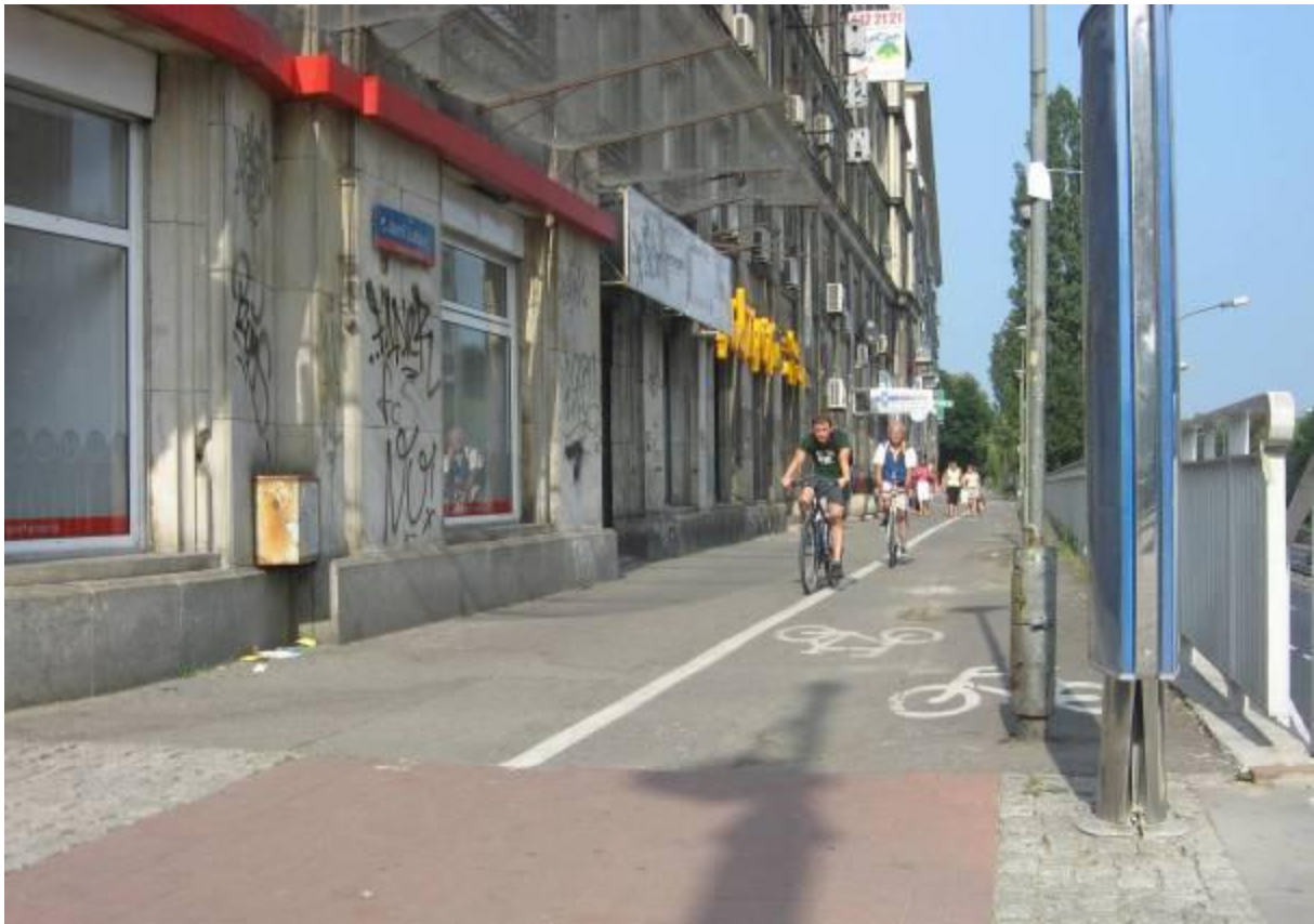
Al. Armii Ludowej/ul. Marszałkowska – latarnie i panel z planem miasta utrudniające ruch po drodze dla rowerów oraz przesunięte względem siebie odcinków dróg dla rowerów.
