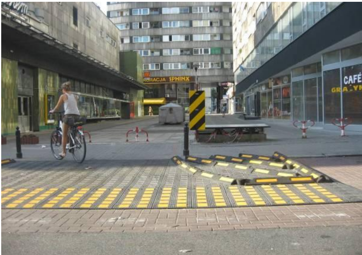
Ul. Moniuszki/Pasaż Witolda Równickiego - próg zwalniający z elementów prefabrykowanych z separatorami i słupkami zmniejszającymi szerokość wjazdu, co dodatkowo przyczynia się do ograniczenia prędkości samochodów, które wjeżdżają tu stosunkowo rzadko ze względu na przeważnie rozłożone blokady parkingowe.
