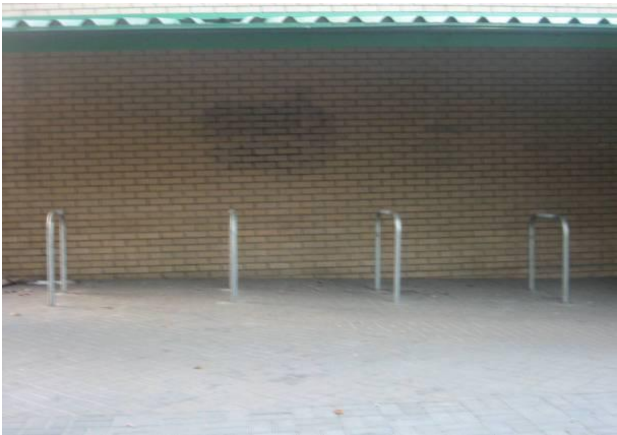
Hala Mirowska – zadaszone stojaki rowerowe przy wejściu.
