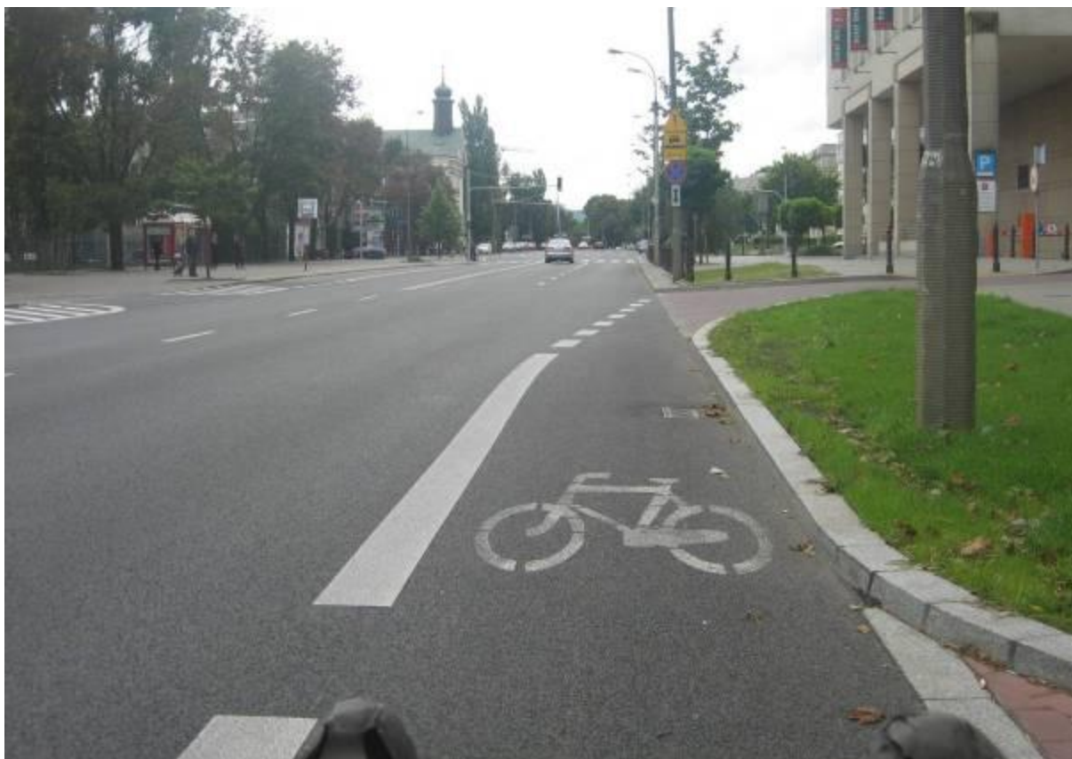
Ul. Bonifraterska- trasa 1. Pas dla rowerów kończy się kilkadziesiąt metrów przed skrzyżowaniem, zamiast być doprowadzony do skrzyżowania i zakończony słuzą rowerową.
