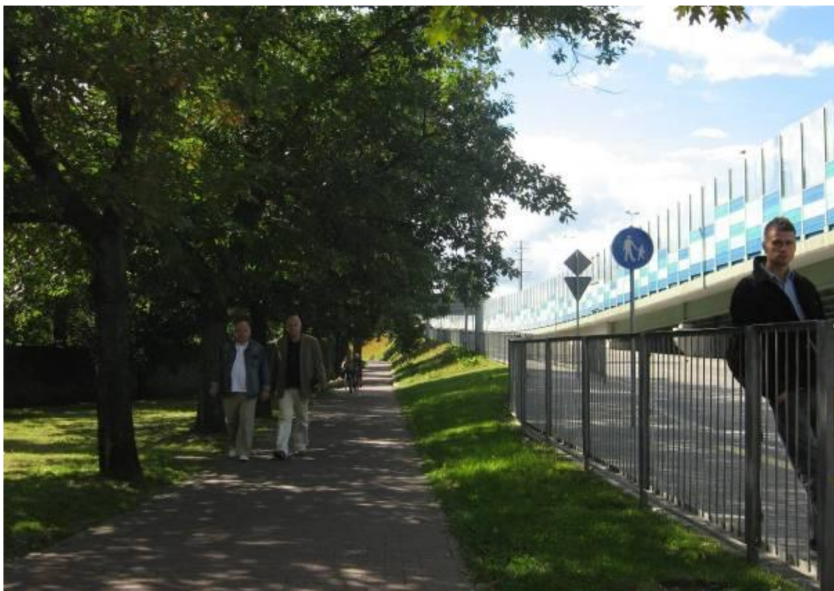
Ul. Starzyńskiego – trasa 1 i 2. Brak chodnika u podnóża nasypu skłania pieszych do chodzenia po drodze dla rowerów, która jest bardziej oddalona od jezdni.
