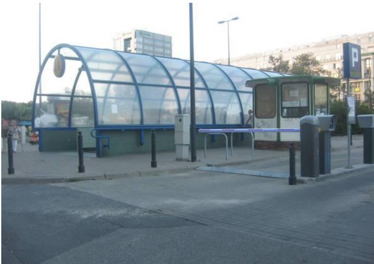
Ul. Zielna/stacja Metra Świętokrzyska - stojaki rowerowe przy budce ochrony parkingu.
