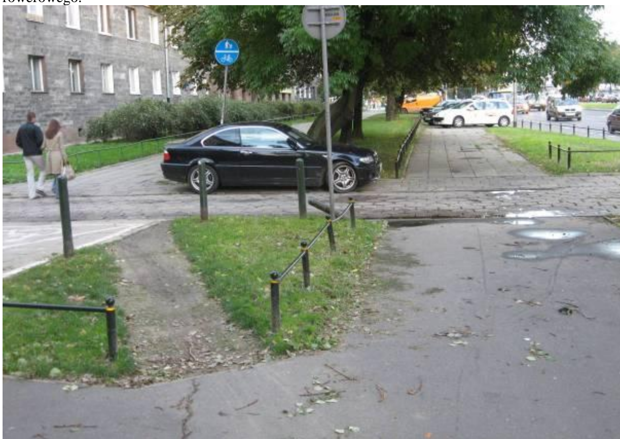
Ul. Bitwy Warszawskiej 1920 r./ul. Grójecka – trasa 4. Połączenie dwóch odcinków ciągu pieszo-rowerowego przez wyjazd z posesji wymagające dwóch skrętów pod kątem prostym i wyjeżdżony przez rowerzystów skrót prowadzący na skos przez trawnik..
