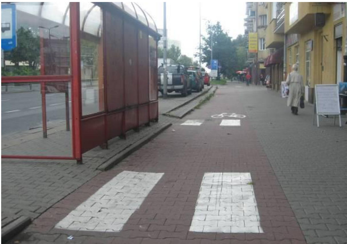
Ul. Sobieskiego – trasa 3. Piesi wychodzą na drogę dla rowerów bezpośrednio zza wiaty przystankowej. Brak widoczności pomiędzy rowerzystami a pieszymi przy wiatach przystankowych jest problemem występującym w wielu miejscach w stolicy.
