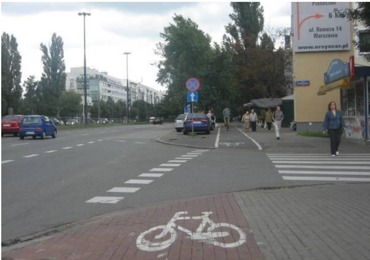
Ul. Sobieskiego – trasa 3. Niewłaściwe oznakowanie poziome przejazdu rowerowego – brak linii wyznaczającej przejazd rowerowy po stronie przejścia dla pieszych.
