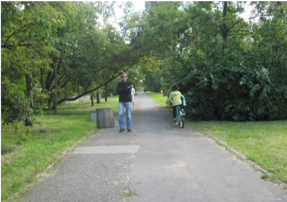
Ul. Wybrzeże Helskie – trasa 2. Jedno z wielu zawężeń szerokości ciągu pieszo-rowerowego przez kosz na śmieci i roślinność w skrajni.
