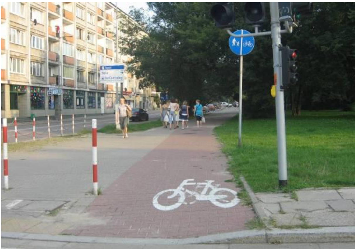
Ul. Topiel - droga dla rowerów na odcinku od. Ul. Oboźnej do ul. Tamka, wykonana z kostki fazowanej.
