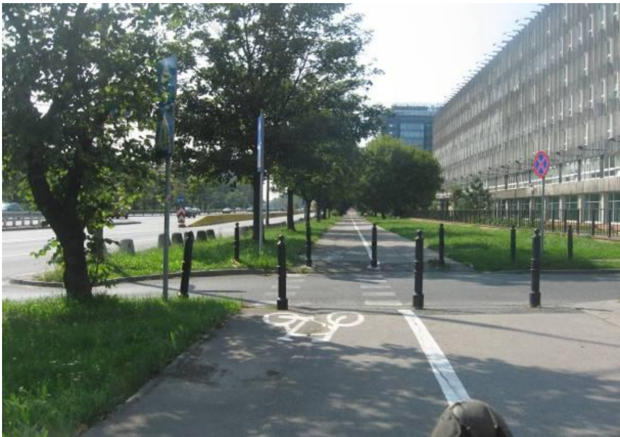
Al. Armii Ludowej/ul. Podolskich – niewłaściwie ustawione i pozbawione elementów odblaskowych słupki utrudniają ruch po drodze dla rowerów.
