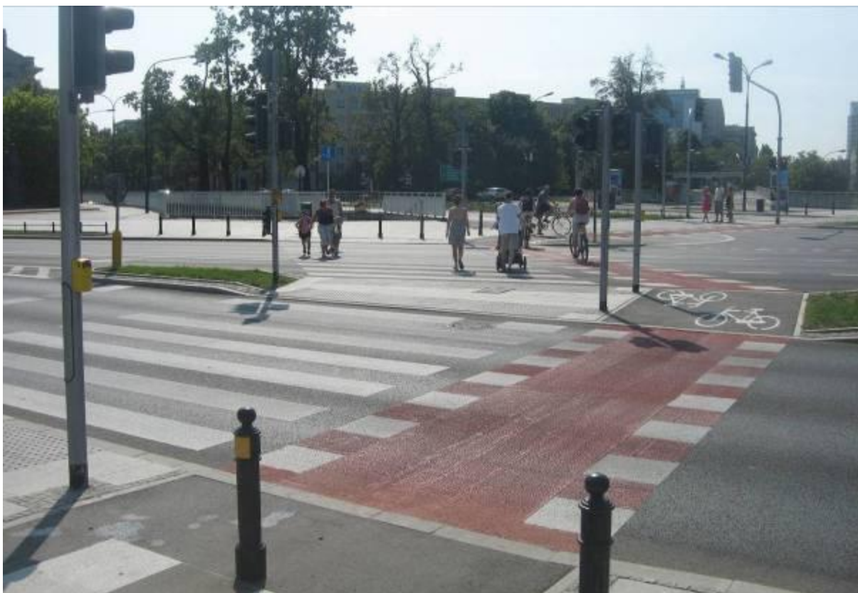
Al. Ujazdowskie/Al. Szucha – przejazdy rowerowe i przejścia dla pieszych. Przed przebudową drogi dla rowerów w Al. Ujazdowskich trzeba było nosić rowery po schodach w przejściu podziemnym.
