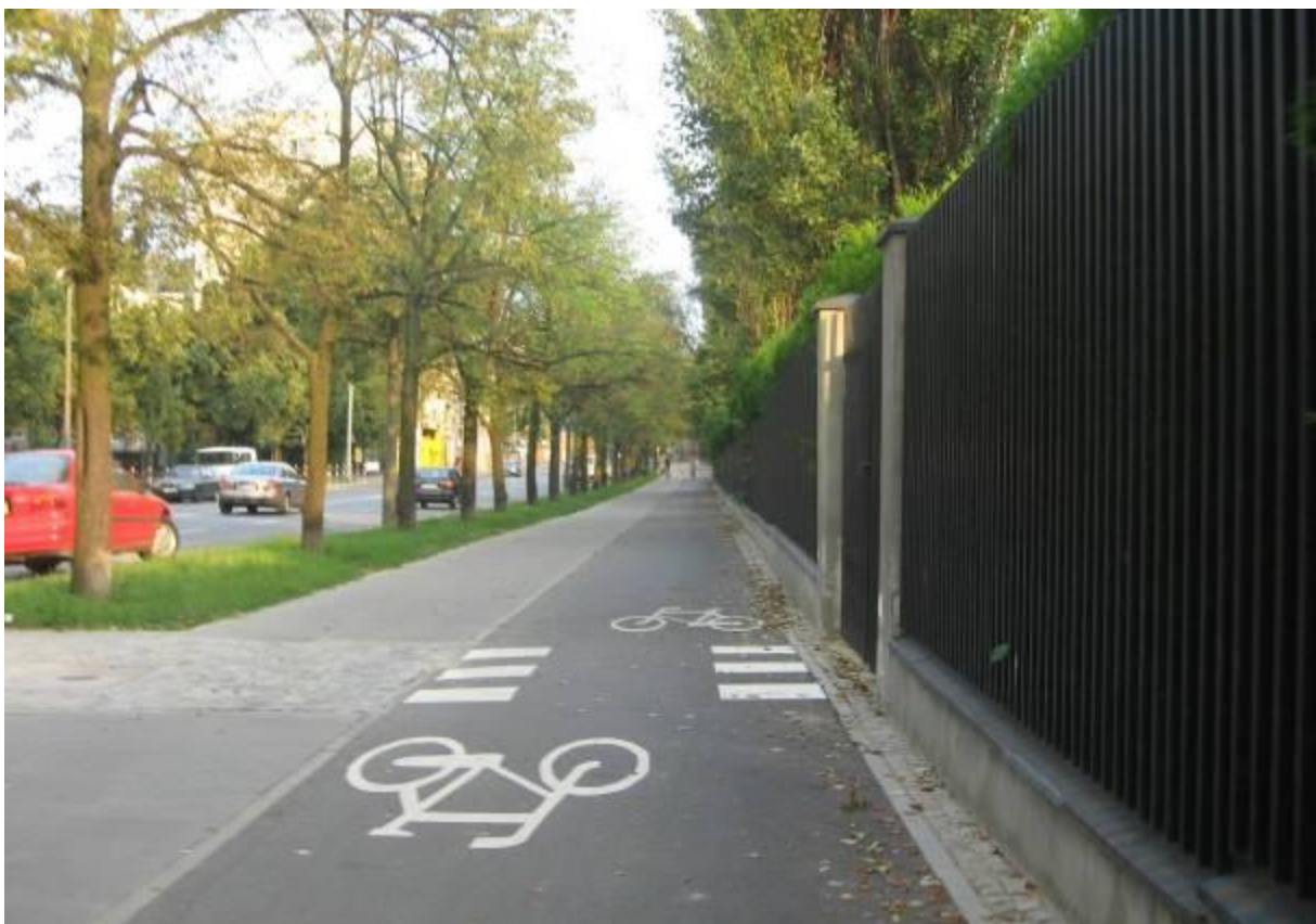
Ul. Kruczkowskiego - droga dla rowerów na odcinku od ul. Tamka do ul. Czerwonego Krzyża, wykonana z asfaltu.
