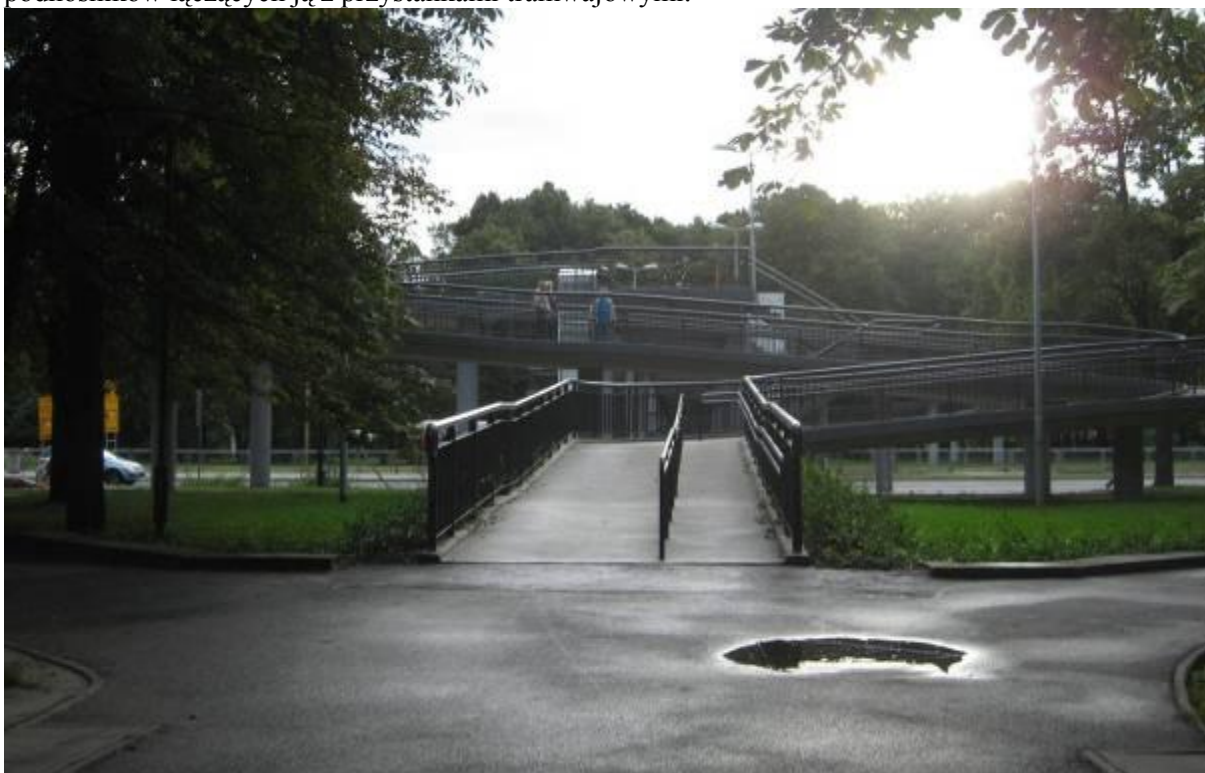
Widok na kładkę nad Al. Niepodległości od strony wschodniej.
