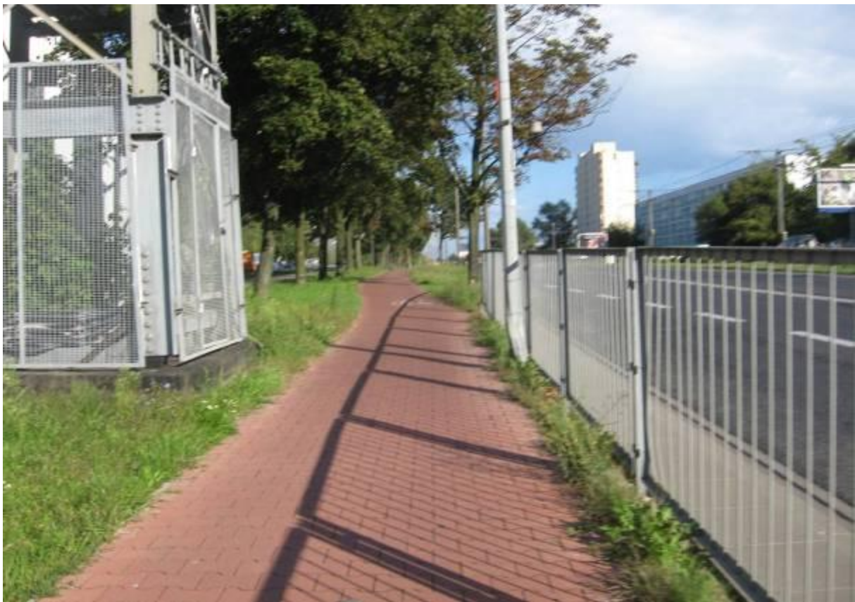
Ul. Broniewskiego – trasa 5. Powszechnie stosowane w Warszawie ogrodzenie segmentowe z pionowymi prętami, o które łatwo zahaczyć kierownicą i latarnia w skrajni drogi dla rowerów.
