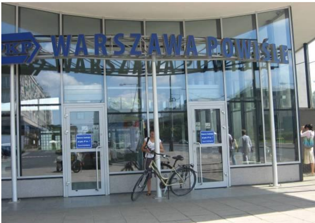
Al. Jerozolimskie/ul. Smolna - umieszczenie stojaków rowerowych w kształcie odwróconej litery „U” przy górnym wejściu na stację PKP Powiśle.
