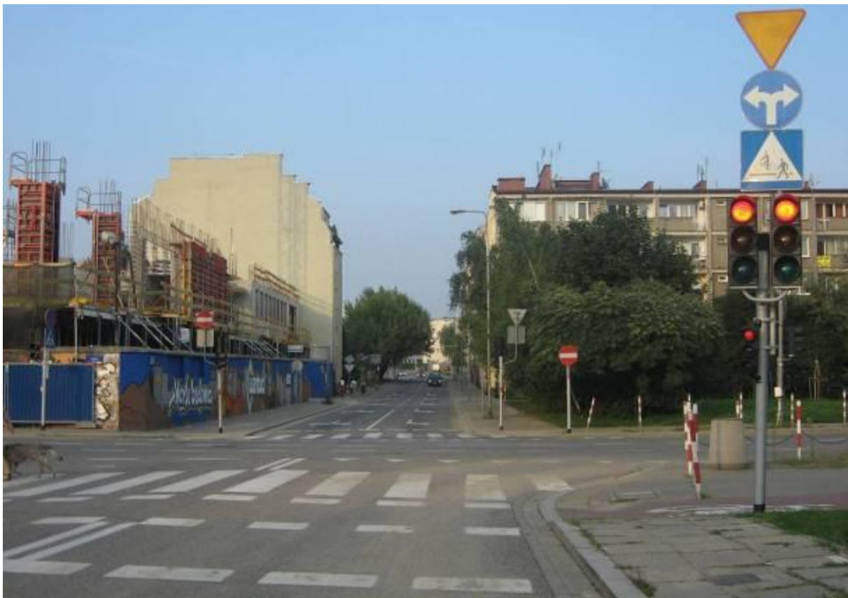
Ul. Zajęcza/ul. Topiel – trasa 2. Brak łącznika umożliwiającego skręt w prawo z jezdni na drogę dla rowerów z pominięciem sygnalizacji świetlnej.
