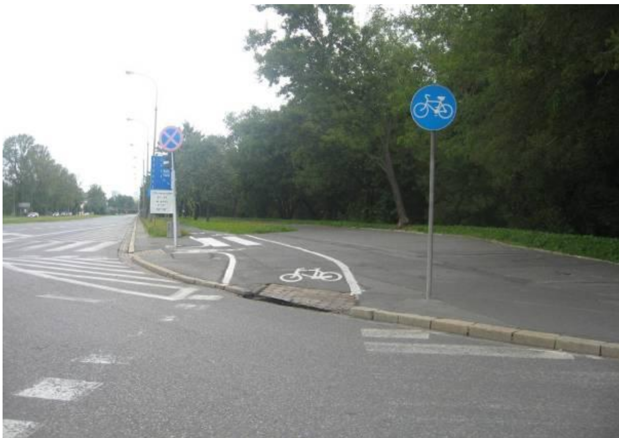
Ul. Sobieskiego/ul. Idzikowskiego – trasa 3. Krawężnik obniżony tylko na części szerokości przejazdu rowerowego.
