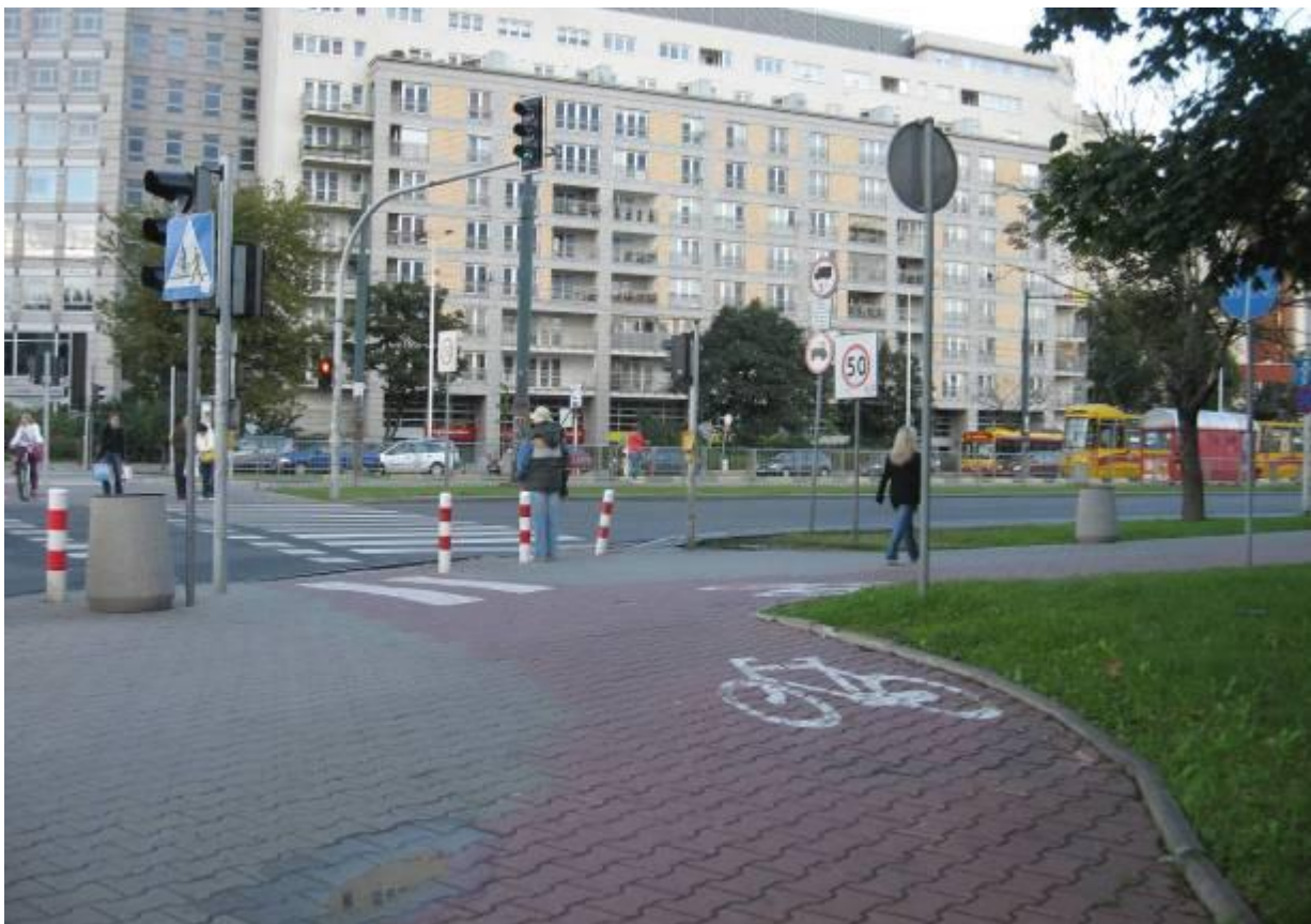
Rondo Zgrupowania AK „Radosław”/Al. Jana Pawła II – trasa 5. Zbyt mały promień skrzyżowania w prawo, pomimo wystarczającej ilości miejsca na łagodny zakręt drogi dla rowerów.
