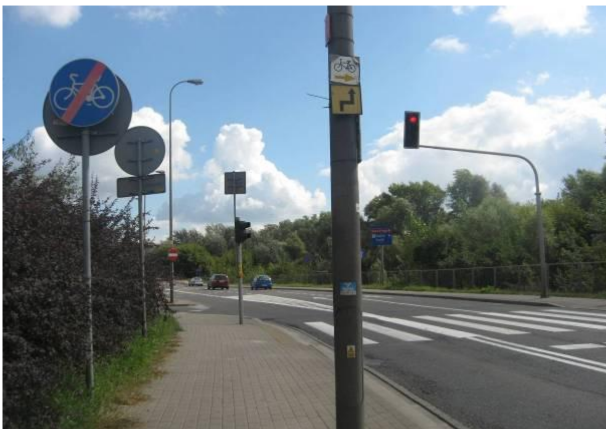
Ul. Wybrzeże Szczecińskie/ul. Okrzei – trasa 2. Brak przejazdu rowerowego na skrzyżowaniu z sygnalizacją świetlną. Identyczne rozwiązanie zastosowano na skrzyżowaniu ul. Wybrzeże Szczecińskie z ul. Ratuszową.
