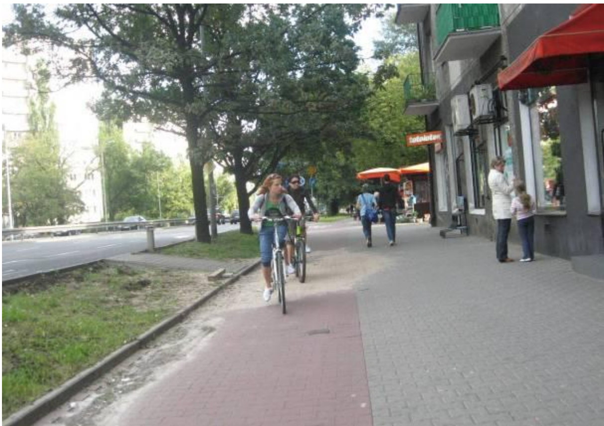
Ul. Sobieskiego – trasa 3. Skutki niewłaściwego odwodnienia drogi dla rowerów.
