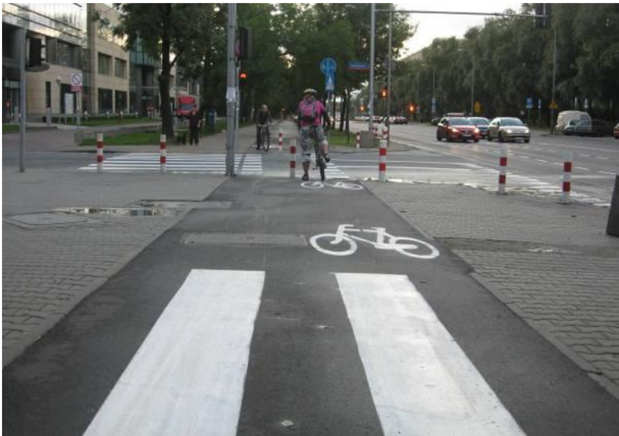
Jeden z nielicznych błędów na ścieżce wzdłuż ul. Bitwy Warszawskiej 1920 r. to słup sygnalizacji świetlnej umieszczony za blisko krawędzi drogi dla rowerów.
