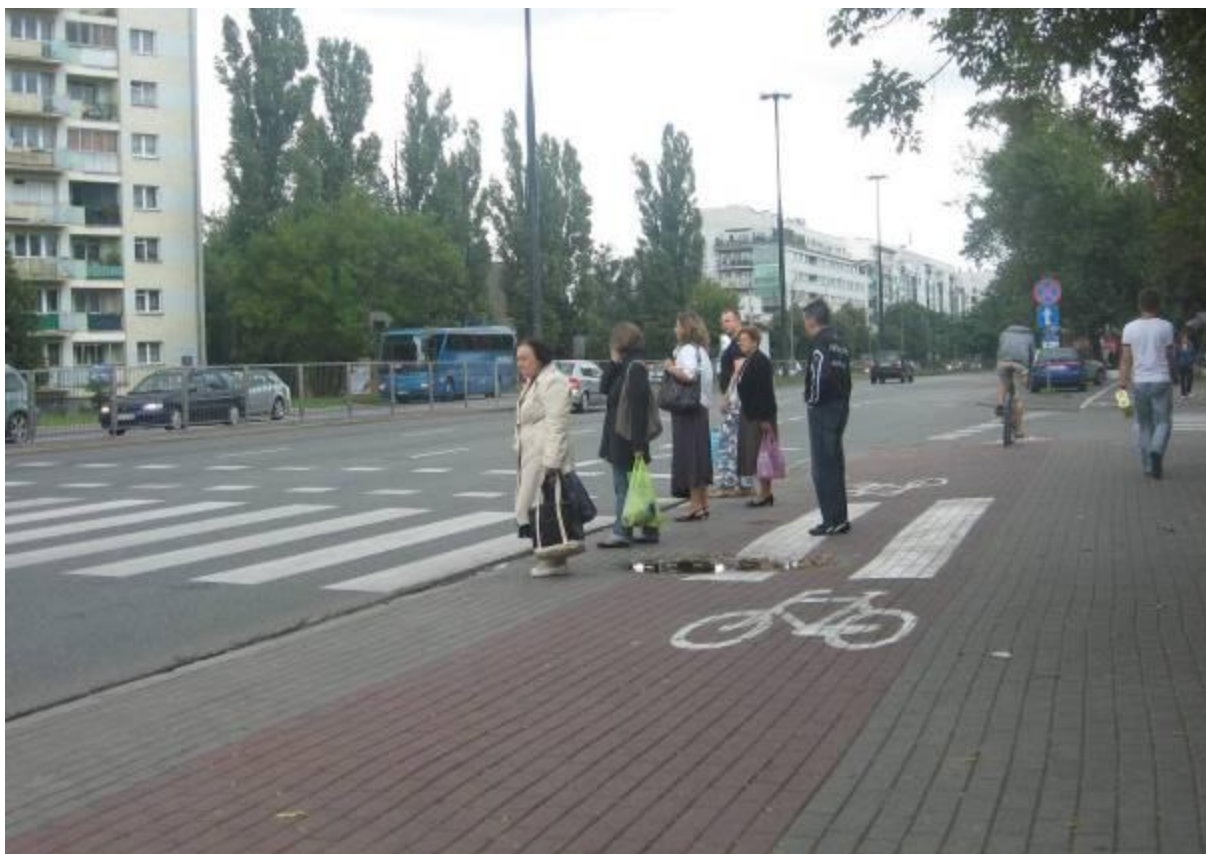
Ul. Sobieskiego/ul. Dolna – trasa 3. Brak miejsca na akumulację pieszych pomiędzy drogą dla rowerów a jezdnią przyczynia się do stania pieszych na drodze dla rowerów w oczekiwaniu na zmianę świateł.
