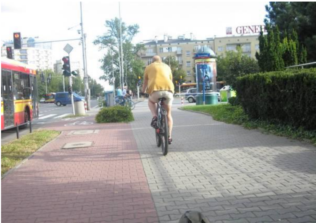
Ul. Belwederska/ul. Spacerowa – trasa 3. Zakręty drogi dla rowerów zmuszające do zwolnienia poniżej 25 km/h pomiędzy szafą sterowniczą sygnalizacji świetlnej a sygnalizatorem, które rowerzyści jadący w tym kierunku omijają po chodniku.
