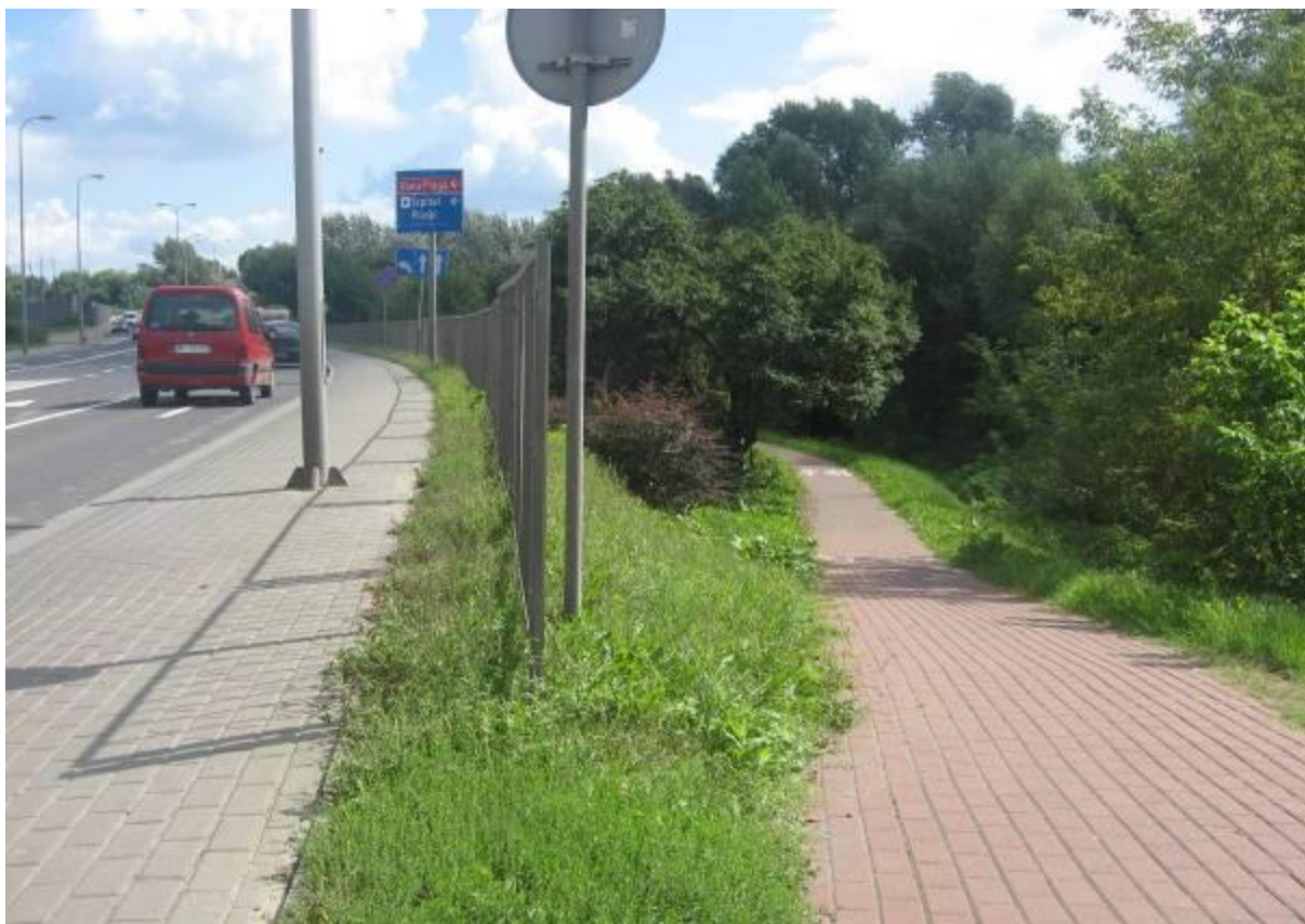
Ul. Wybrzeże Szczecińskie/ul. Okrzei – trasa 2. Droga dla rowerów na odcinku kilkudziesięciu metrów znajduje się w zagłębieniu, co zmusza do niepotrzebnego pokonywania różnicy wysokości w obydwu kierunkach, co sprawia, że część rowerzystów wybiera jazdę chodnikiem przy jezdni.
