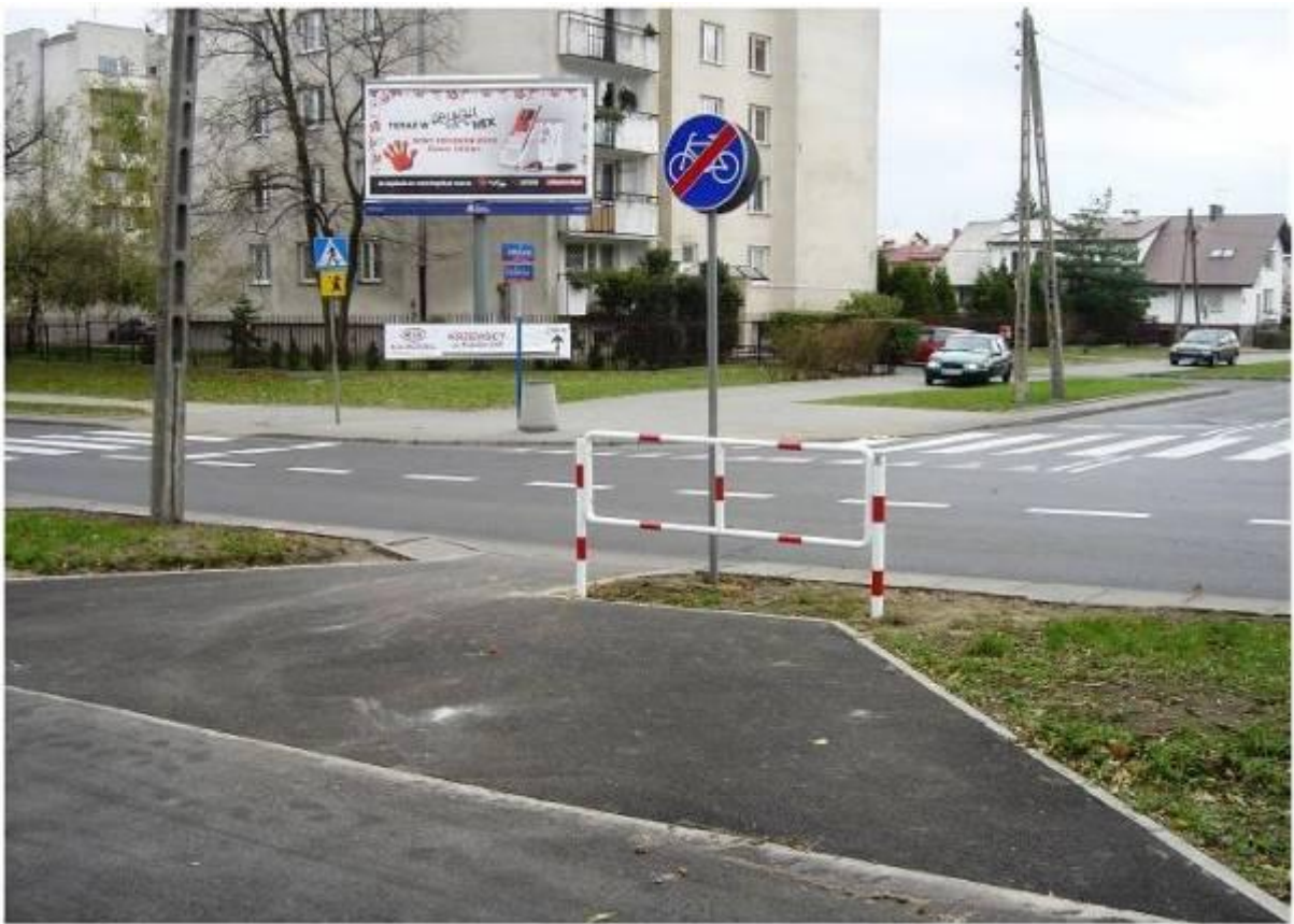
Włączenie drogi dla rowerów w jezdnię jako czwarty wlot skrzyżowania na ul. Podlesnej.
