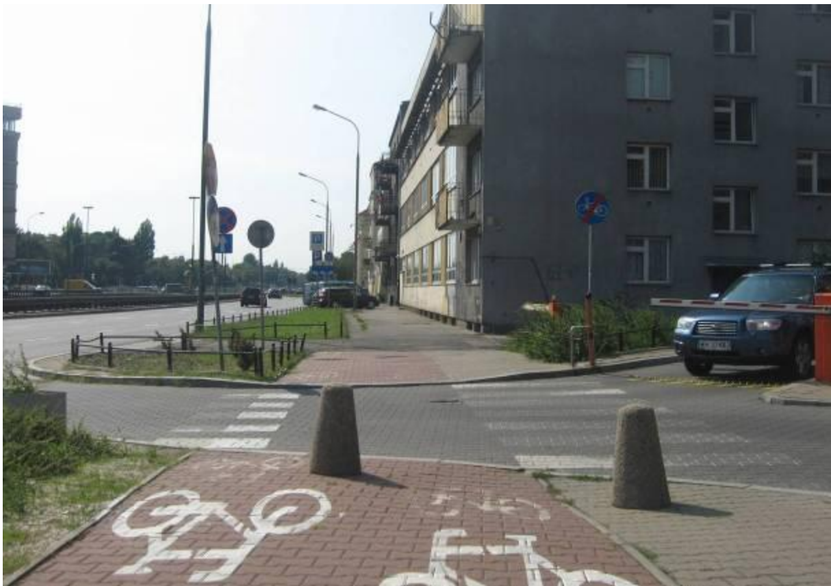
Al. Armii Ludowej pomiędzy ul. Rektorską a ul. Lekarską – zakończenie drogi dla rowerów pomiędzy skrzyżowaniami.
