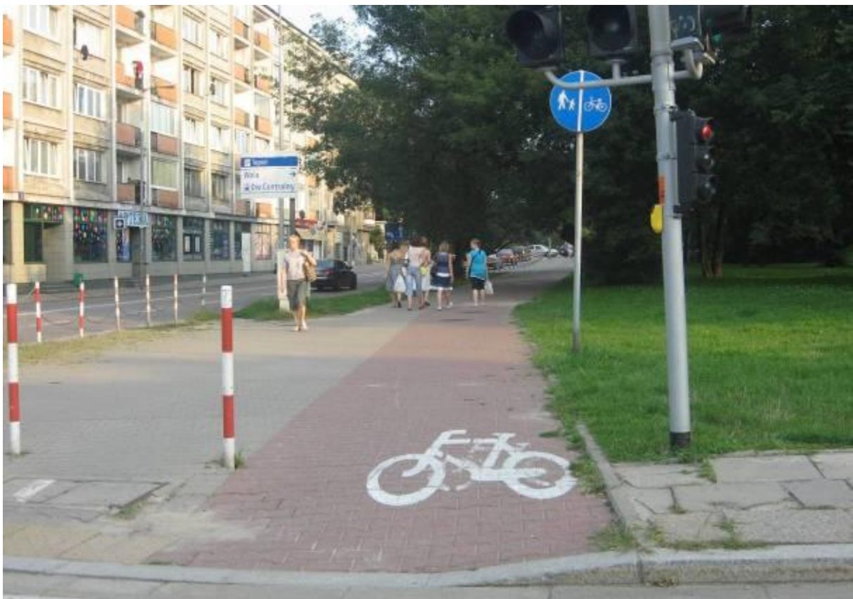
Ul. Zajęcza/ul. Topiel – trasa 2. Krawężnik obniżony na niecałej szerokości przejazdu rowerowego oraz słupki w skrajni drogi dla rowerów (po lewej stronie przejazdu rowerowego).
