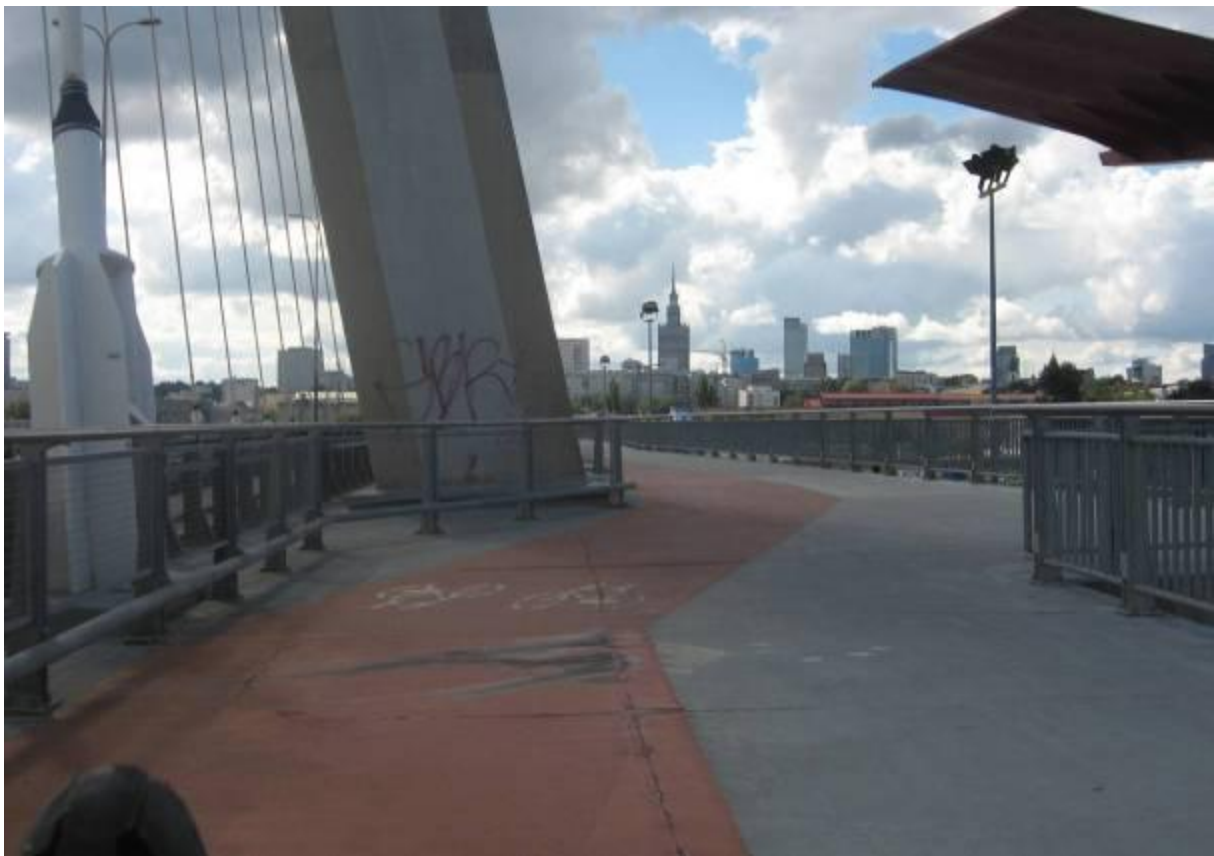
Most Świętokrzyski – trasa 2. Ograniczenie widoczności przy pylonie mostu. W podobny sposób przeprowadzono drogę dla rowerów przy kładkach pieszych nad ul. Sobieskiego.
