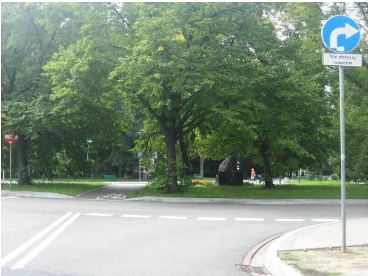
Włączenie drogi dla rowerów w jezdnię jako czwarty wlot skrzyżowania z ul. Czerniakowską na przedłużeniu ul. Wilanowskiej.
