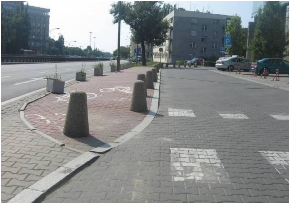
Al. Armii Ludowej pomiędzy ul. Rektorską a ul. Lekarską – betonowe słupki stojące na drodze dla rowerów i wystająca na nią donica.
