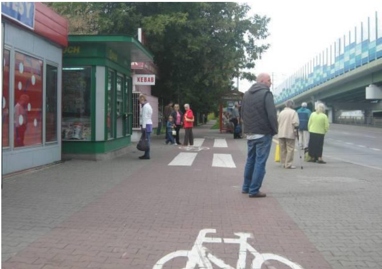
Ul. Starzyńskiego – trasa 1 i 2. Brak bariery oddzielającej chodnik od drogi dla rowerów w rejonie przystanku autobusowego. Niewystarczająca przestrzeń dla pieszych i rowerzystów.
