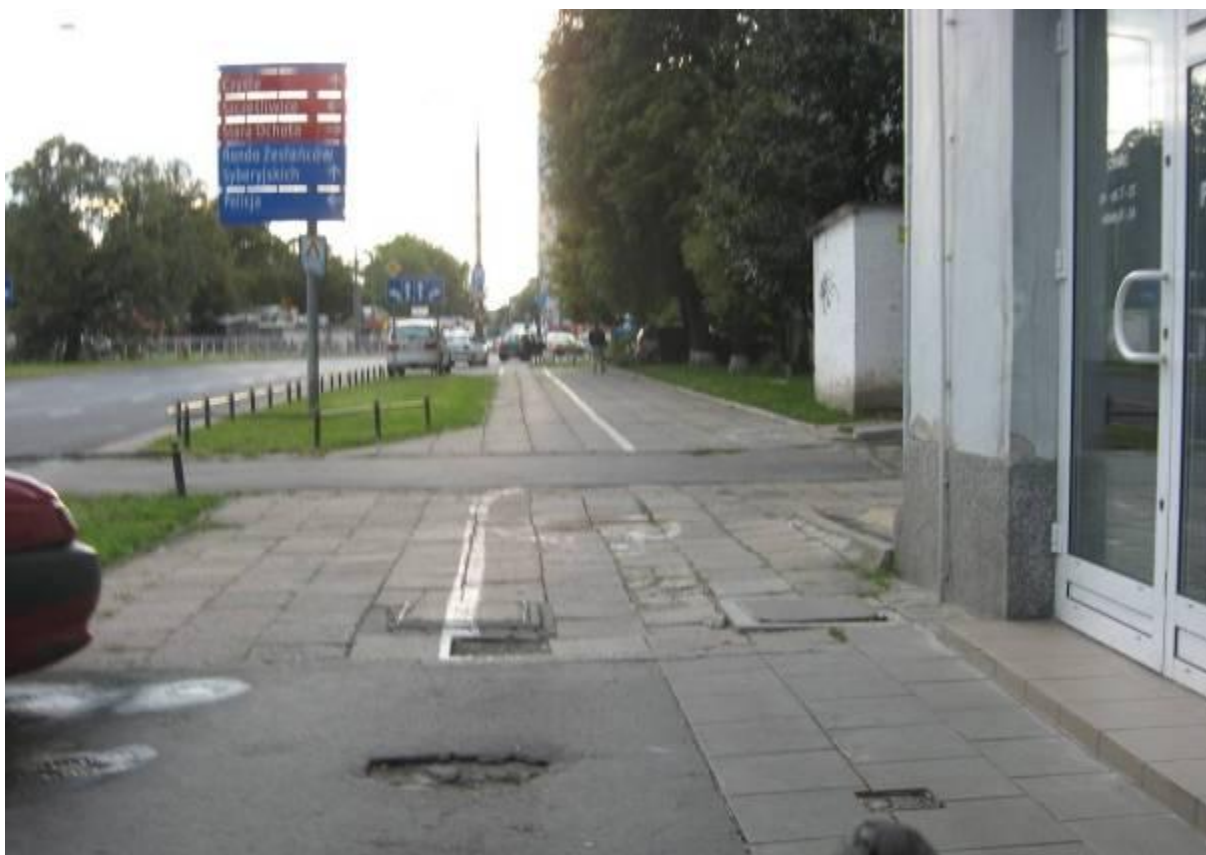
Ul. Banacha/ul. Grójecka – trasa 4. Na tym odcinku oznakowanie pionowe sprzeczne z oznakowaniem poziomym pozostawiono, więc rowerzyści powinni jeździć obok otwierających się na zewnątrz budynku drzwi.
