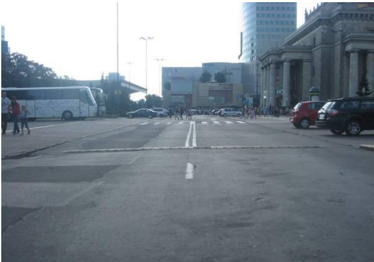
Progi zwalniające w strefie ograniczenia prędkości do 10 km/h na drodze wewnętrznej wokół Pałacu Kultury i Nauki.
