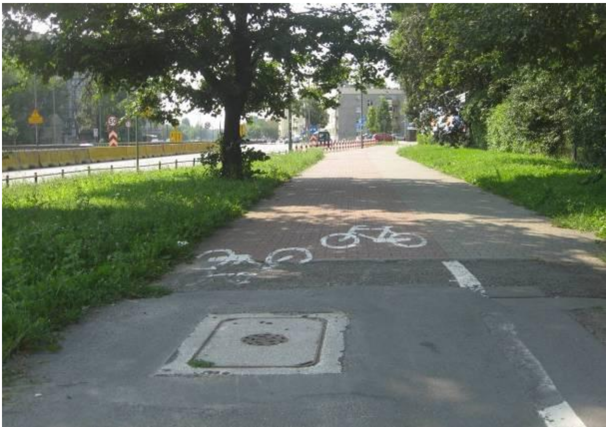
Al. Armii Ludowej – droga dla rowerów na odcinku od ul. Podolskich do ul. Lekarskiej, wykonana z na połowie długości z asfaltu a na połowie z kostki fazowanej.
