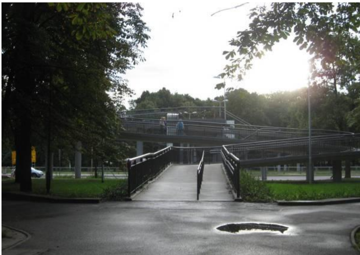
Kładka pieszo-rowerowa nad Al. Niepodległości – trasa 4. Zbyt małe promienie łuków i zwężenia powodujące konieczność przepuszczania się rowerzystów.
