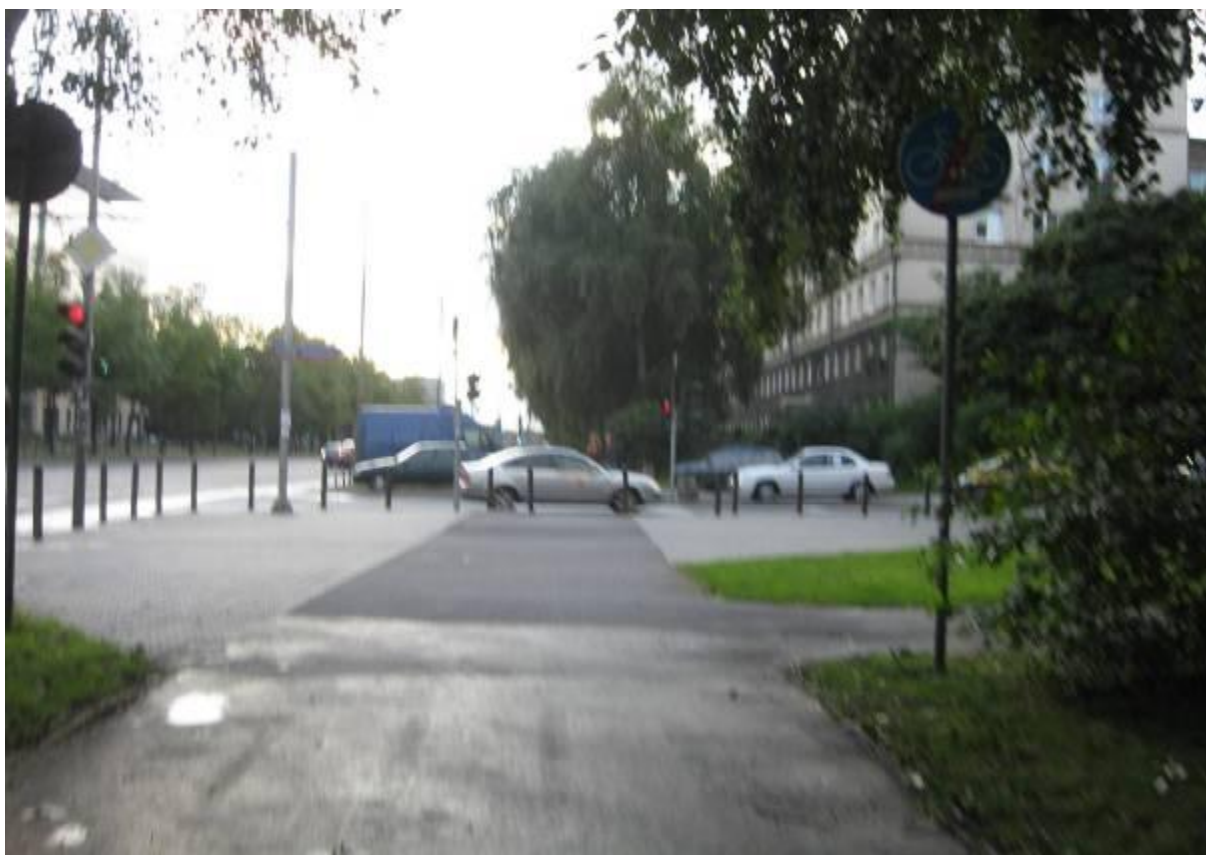
Ul. Bitwy Warszawskiej 1920 r./Białobrzaska – trasa 4. Przejazdów rowerowych po stronie ulicy, po której znajduje się ciąg pieszo rowerowy brakuje także na pozostałych skrzyżowaniach, zarówno tych z sygnalizacją świetlną, jak i bez niej. Podobnie wygląda organizacja ruchu na całej długości ul. Banacha.
