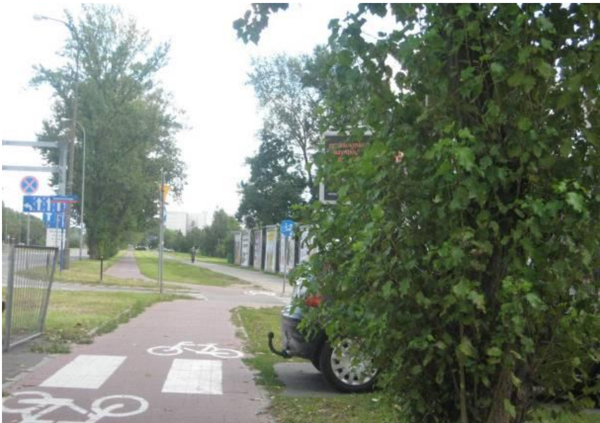
Ul. Sobieskiego/ul. Kostrzewskiego - trasa 3. Krzew oraz parkowanie na chodniku ograniczające widoczność bezpośrednio przy przejściu dla pieszych przez drogę dla rowerów.
