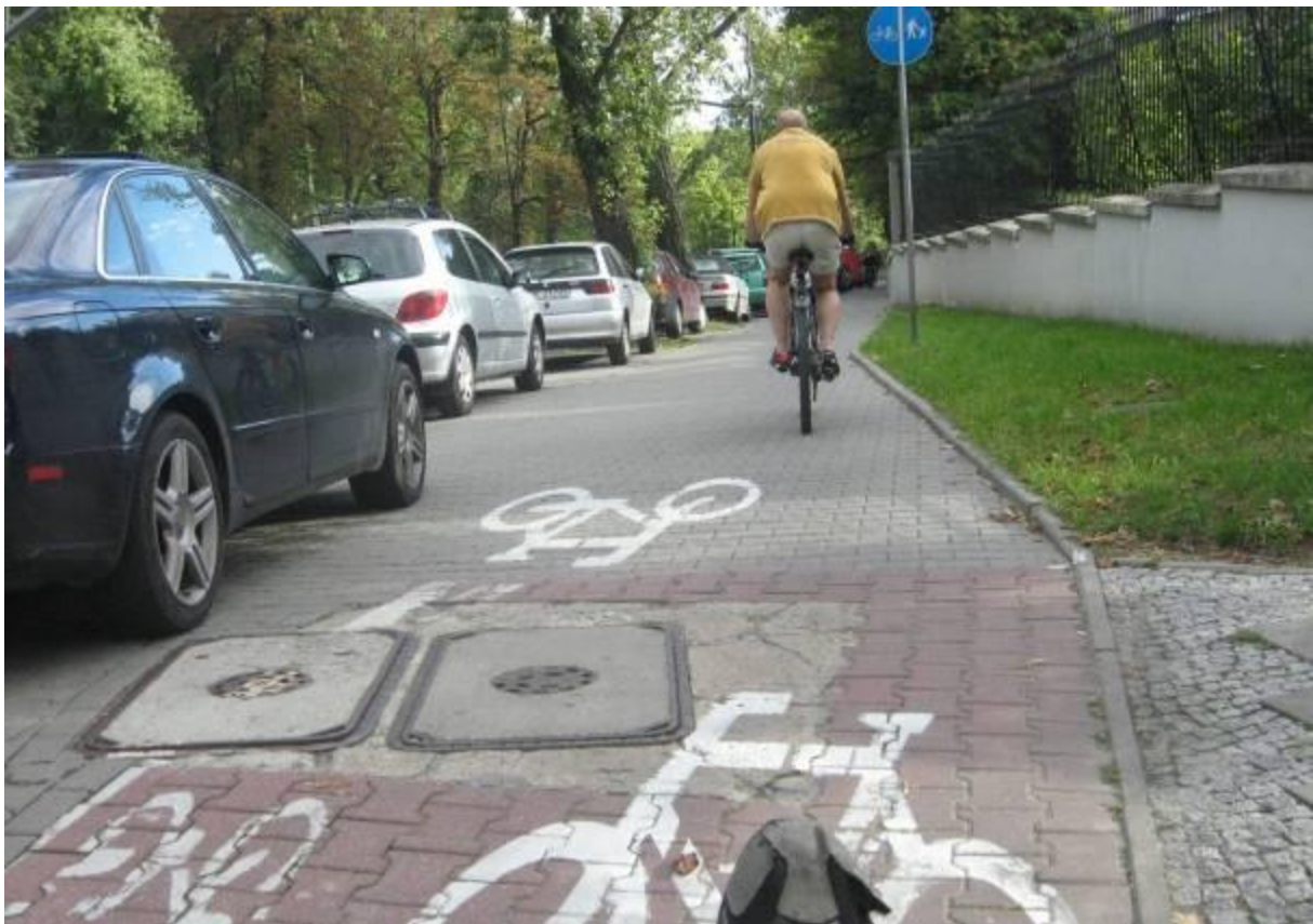
U1. Belwederska/ul. Klonowa – nieprawidłowe oznakowanie pionowe – w tym miejscu droga dla rowerów przechodzi w ciąg pieszo-rowerowy, a więc na znaku symbole pieszych i roweru powinny być rozdzielone poziomą kreską.
