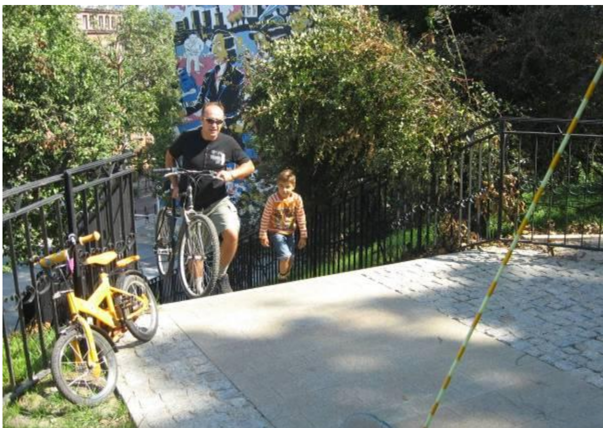
Umieszczenie na schodach kładki nad ul. Tamka prowadnic dla rowerów i wózków.
