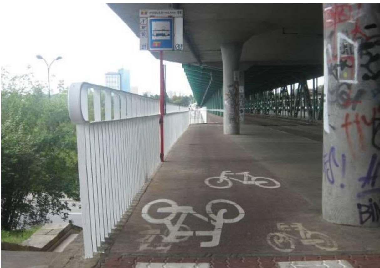
Most Gdański – trasa 1. Słupy z rozkładem jazdy umieszczone na barierze na obydwu przystankach tramwajowych na moście przyczyniają się do stania pasażerów oczekujących na tramwaj na drodze dla rowerów (przeniesione po interwencjach).
