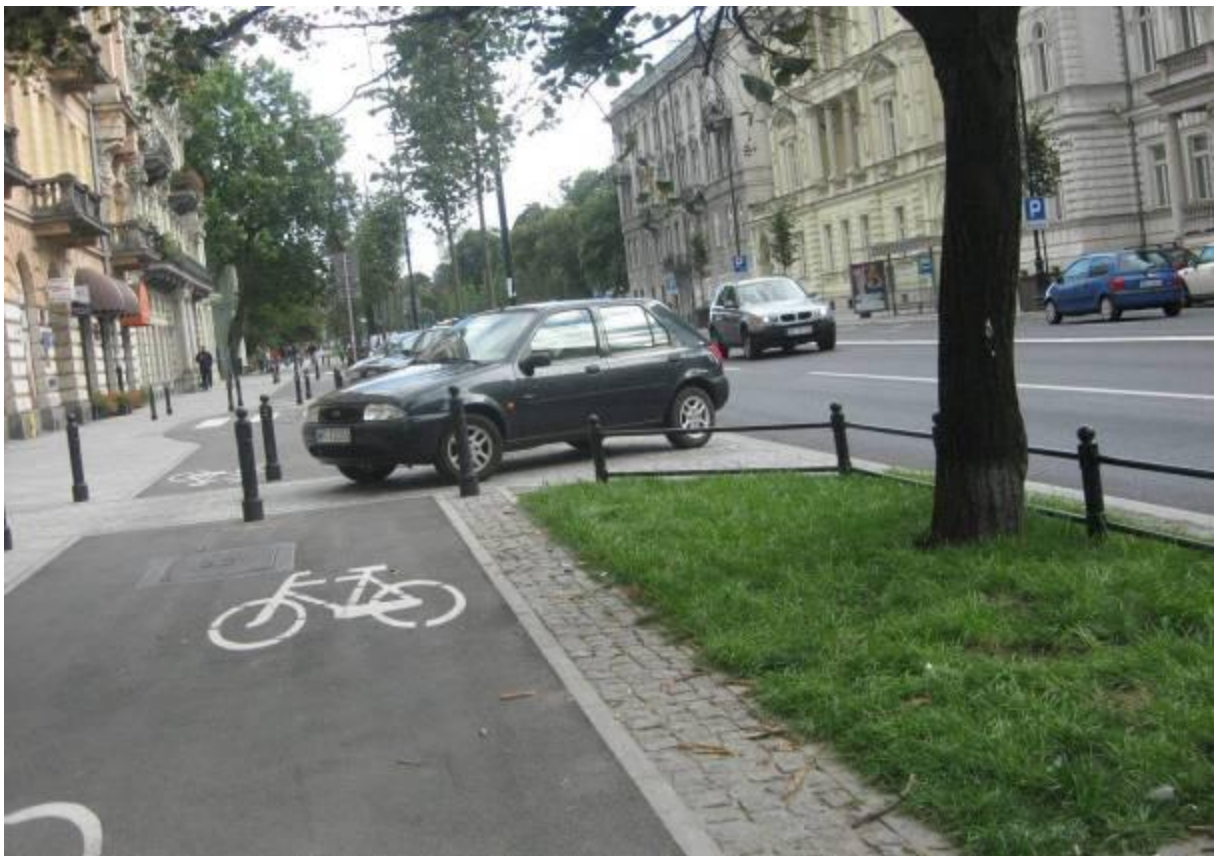
Al. Ujazdowskie/Pl. Trzech Krzyży – trasa 3. Samochód parkujący na wjeździe bramowym w poprzek drogi dla rowerów. Do tej sytuacji przyczynia się brak ciągłości nawierzchni drogi dla rowerów i brak oznakowania poziomych przejazdów rowerowych, które zostały negatywnie zaopiniowane przez konserwatora zabytków.
