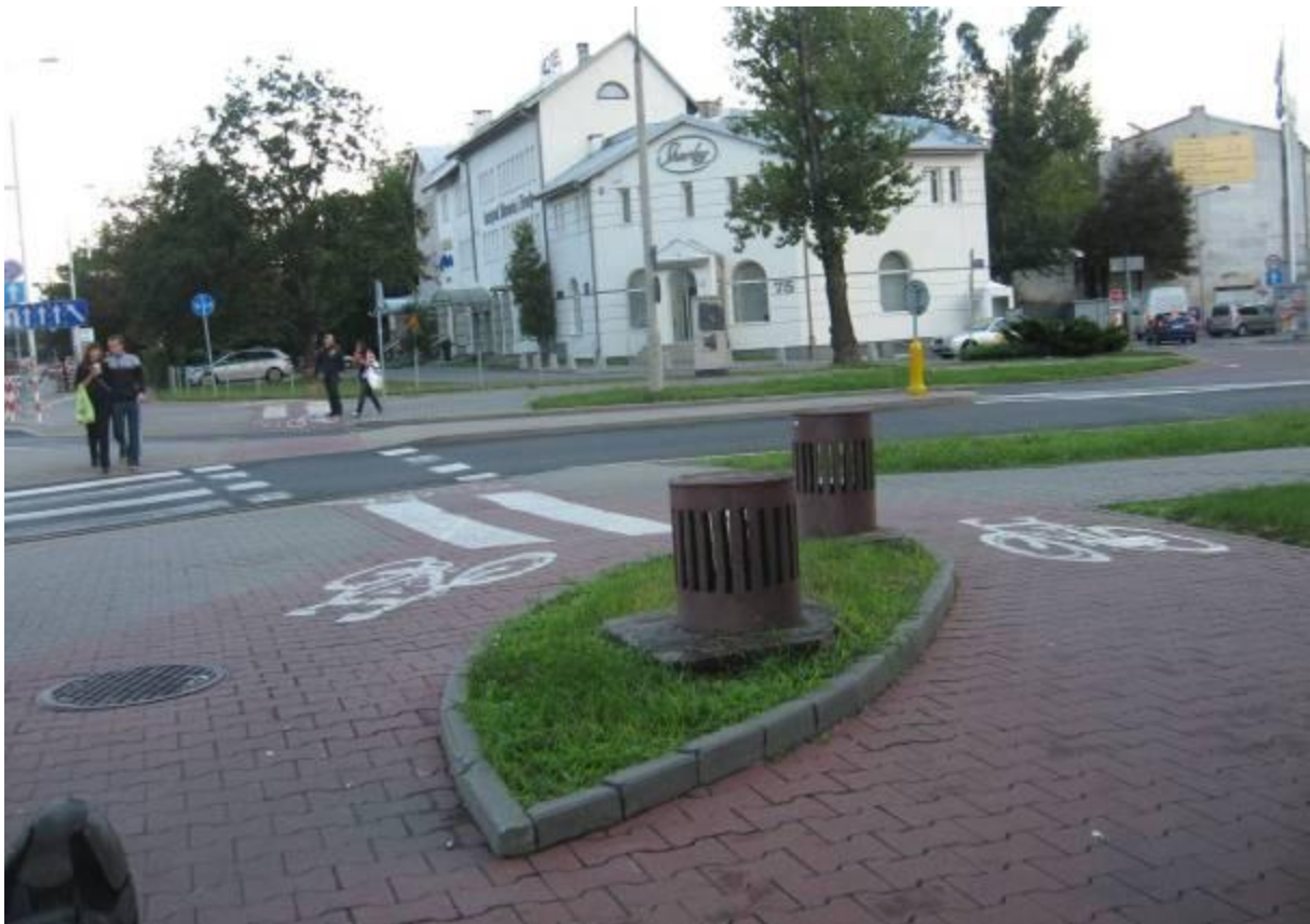
Al. Jana Pawła II/ul. Dzika – trasa 5. Brak oznakowania elementami odblaskowymi przeszkody w osi drogi dla rowerów, która jest od tej strony dodatkowo zasłonięta przez drzewo.
