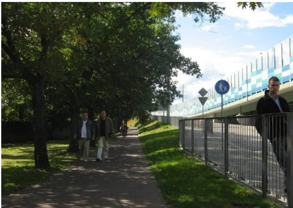
Budowa chodnika obok drogi dla rowerów u podnóża nasypu Mostu Gdańskiego.
