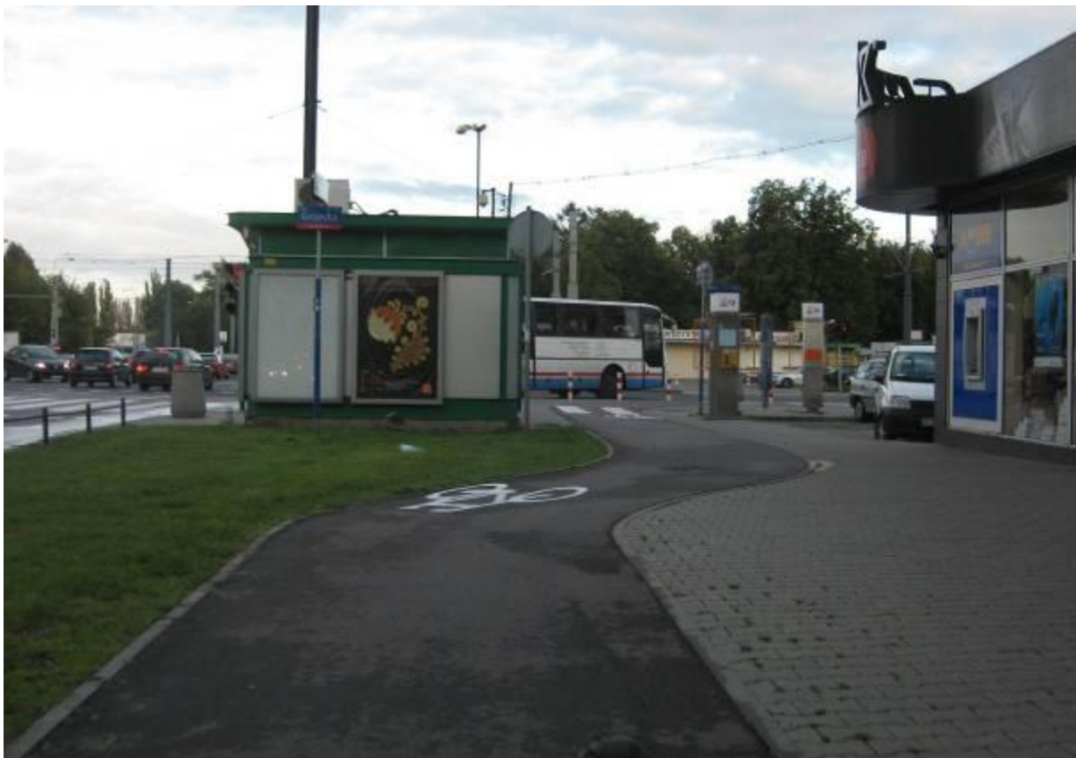
Prawidłowe wyłukowanie zakrętów i zachowanie odstępu pomiędzy drogą dla rowerów a kioskiem ograniczającym widoczność.
