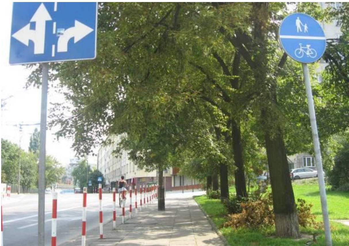
Ul. Browarna/ul. Oboźna - zwężenie ciągu pieszo-rowerowego przy latarni poniżej 1,5m.
