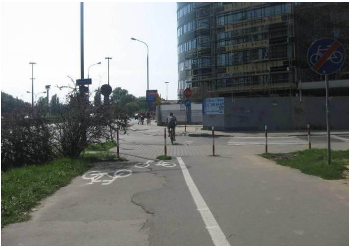
Al. Armii Ludowej/ul. Mokotowska – słupki utrudniające ruch po drodze dla rowerów i znak końca drogi dla rowerów przed ulicą pomimo wyznaczenia przez nią przejazdu rowerowego.
