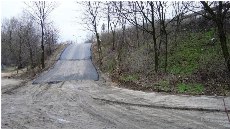
Ilustracja 1. Zjazd techniczny wykonany dla potrzeb remontu estakad
