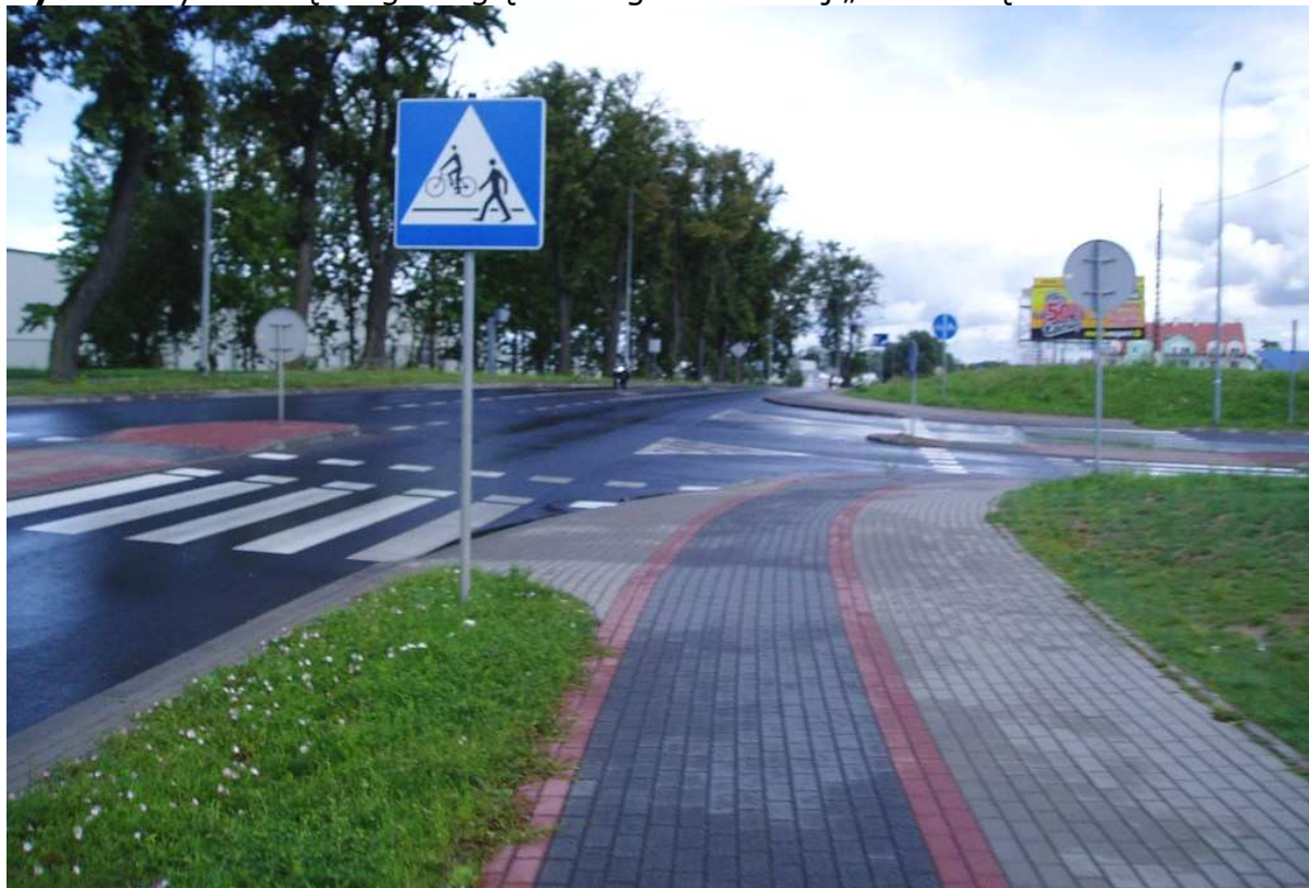
Rys. 1 Przykład błędnego odgięcia drogi rowerowej „na zewnątrz”.
