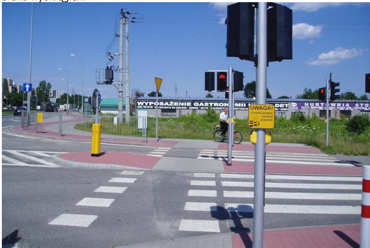
Rys. 2 Przykład błędnego odgięcia drogi rowerowej „na zewnątrz”, ale także braku wyokrąglenia.
