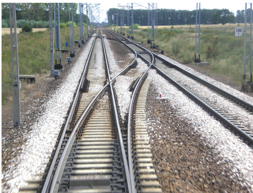
Fot. 2. Zastosowane na wszystkich polskich modernizacjach najtańsze rozjazdy ograniczają prędkość na kierunku skrzyętym do 40 km/h. Za granicą stosuje się powszechnie zasadę, że rozjazdy powinny umożliwiać skręt z połową prędkości dopuszczalnej na szlaku.
