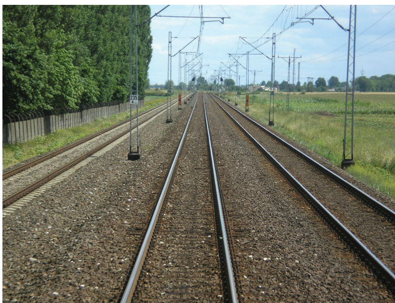
Fot. 3. Na linii E20 pomiędzy Kutnem i Poznaniem powszechnie oszczędzono pozostawiając stare tory na drewnianych podkładach, ograniczając się do ich szlifowania i wymiany podtorza. Pieniądzy jednak nie zabrakło na pełną wymianę – z użyciem najwyższej klasy materiałów – toru dodatkowego pomiędzy Słupcą i Strzałkowem, który nie jest nawet zelektryfikowany.
