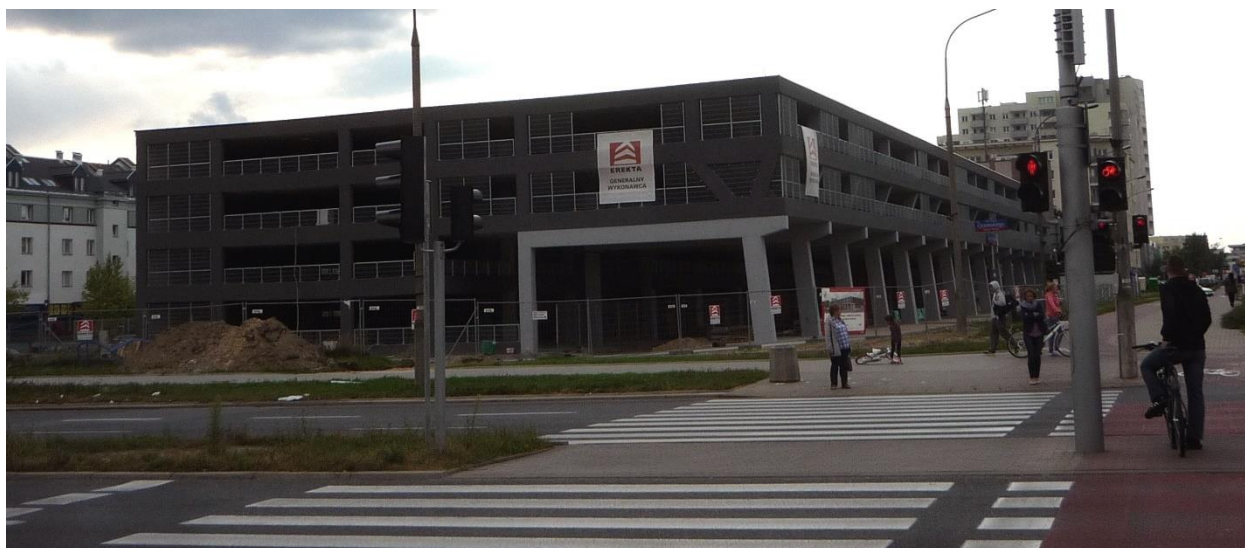
Fotografia 11. Parking PiJ Stokłosy przy al. KEN w trakcie budowy
