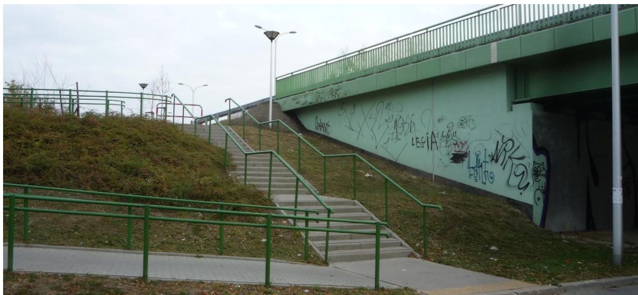
Fotografia 6. Al. KEN – wiadukt (bez chodników i DDR) nad ul. Bacha
